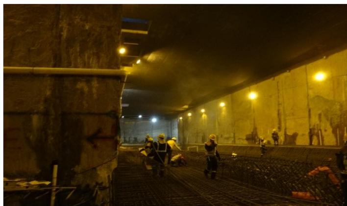
**Foto 20.** Armado de Estructura en Túnel la Magdalena
