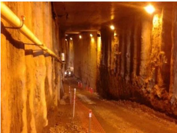
**Foto 54.- Iluminación del túnel en la Estación La Magdalena.**
