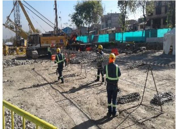
**Fotos 38 y 39.- Soportes para realizar actividades de armado y soldadura de hierro de estructuras para pantallas y pilotes para evitar que el personal adopte posturas inadecuadas ergonómicamente.**
