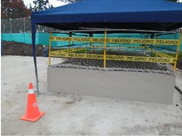
Foto 47.- Se verifica que la Contratista coloca la red de protección, alrededor de los ductos de ventilación como medida preventiva ante cualquier situación que pueda presentarse, Estación La Carolina..
