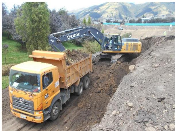
Fotos 21 y 22.- Carga y transporte de material de excavación en Patio de Talleres y Patio de Dovelas-Sur.
