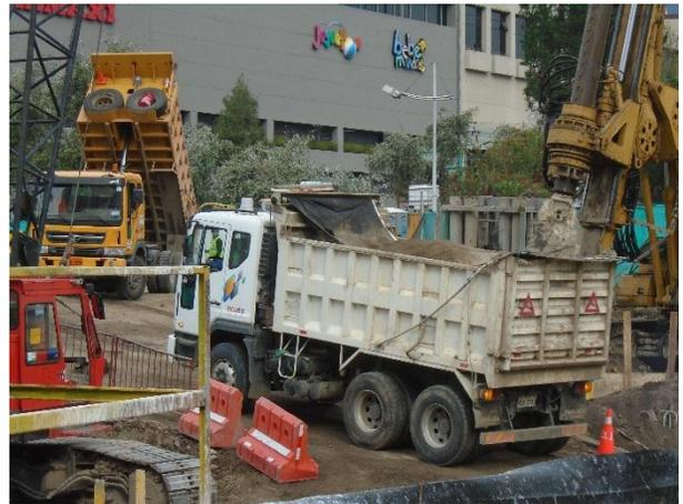
**Fotos 22 y 23.- Transporte de material de excavación.**
