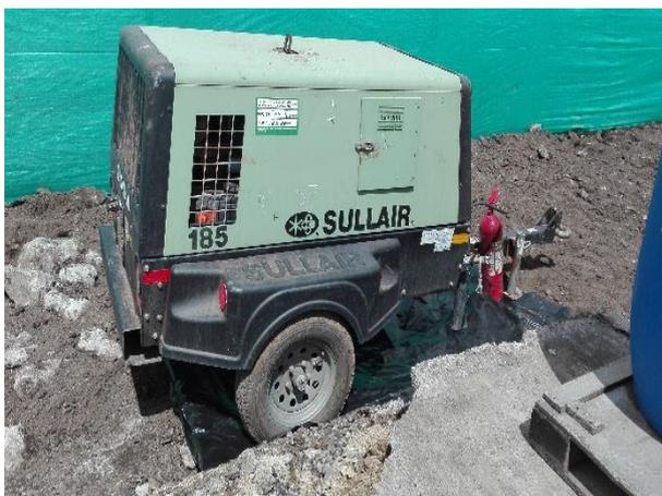
**Foto 15.- Colocación de cubeto bajo compresor – Estación El Recreo.**
