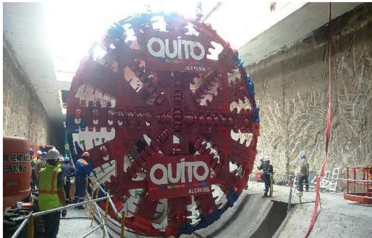
**Foto 37.** Armado y Escudo de Tuneladora
