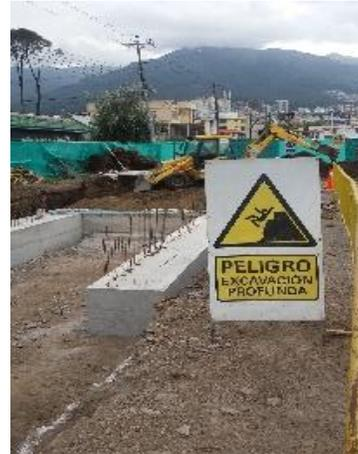
**Fotos 48 y 49.- Colocación de vallas metálicas y señalización en el sitio de obra/Estación Jipijapa.**
