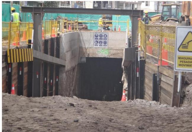
**Foto 32.** Excavación inicial de Túnel
