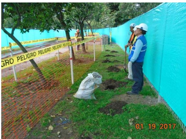
**Foto 33.- Aplicación de mulch en sección vertical, especies protegidas en zona de construcción de colector – Estación El Ejido.**
