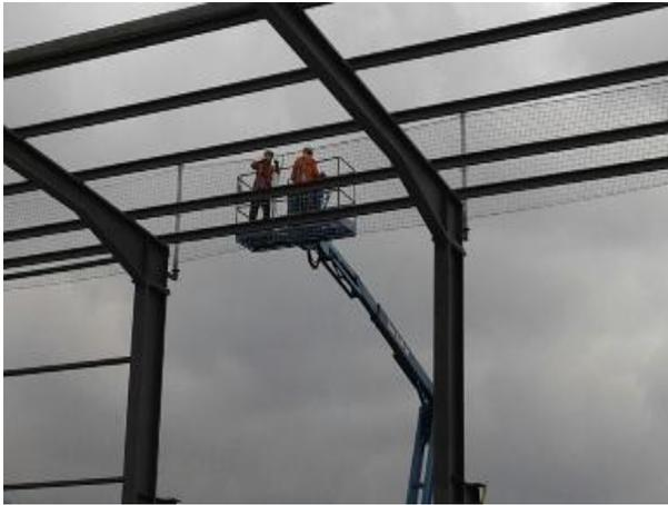
Foto 34.- Uso del elevador y malla de seguridad para el personal que realiza trabajos de montaje de vigas para cubierta en el Patio de Dovelas-Sur.
