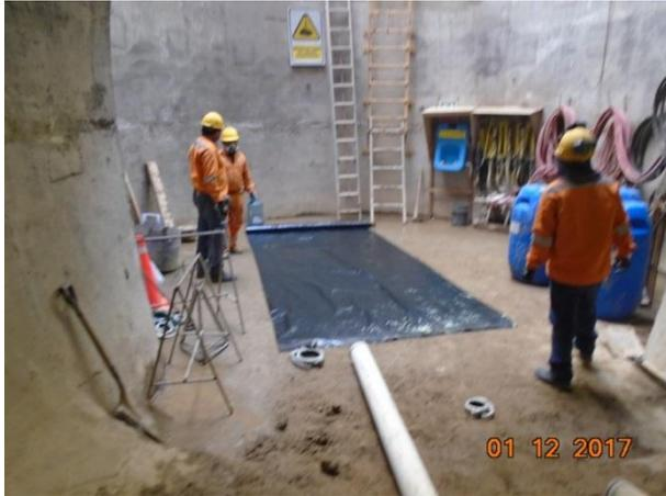
**Foto 12.- Protección del suelo con geomembrana durante actividad de lanzado con bomba – Santa Clara.**
