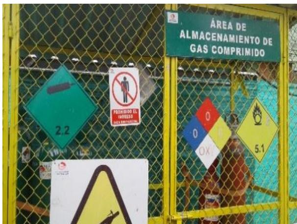
**Foto 51.- Islas de almacenamiento de oxígeno y acetileno que se disponen en los frentes de obra del Proyecto, cuentan con señalización, etiquetado y MSDS de dichos productos.**
