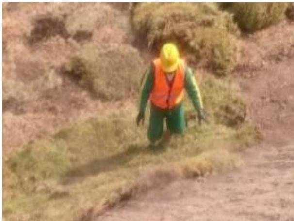
**Foto 13.- Colocación de chamba para protección de talud en Dovelas Sur.**
