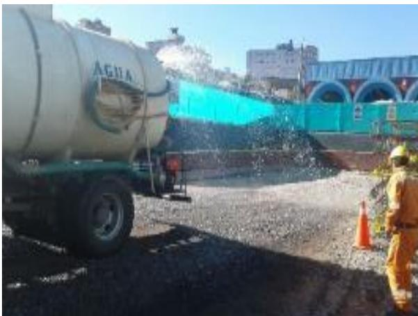
**Foto 3.- Hidratación del suelo descubierto Estación El Recreo.**
