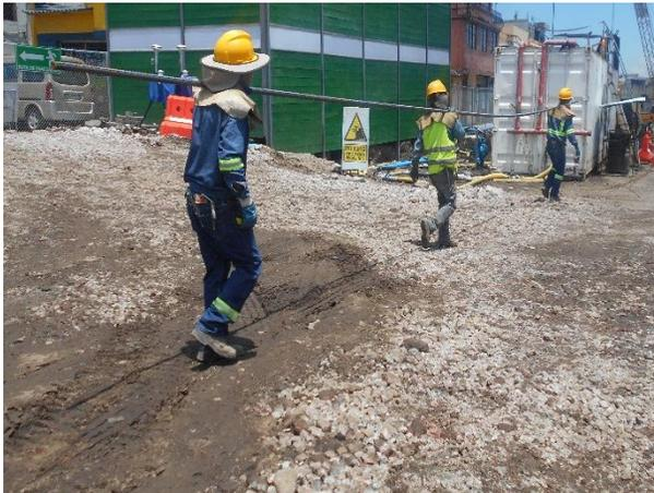
**Foto 44.- Uso de almohadillas por parte del personal que realiza la carga de varillas (no mayor a 23 kg y en trayectos cortos controlados +/- 10 m).**
