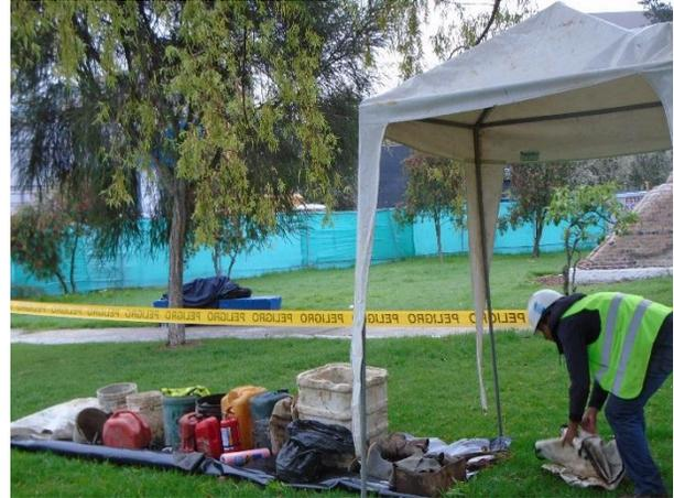
**Fotos 9 y 10.- Colocación de geomembranas para protección del suelo en actividades de sondeo geológico.**
