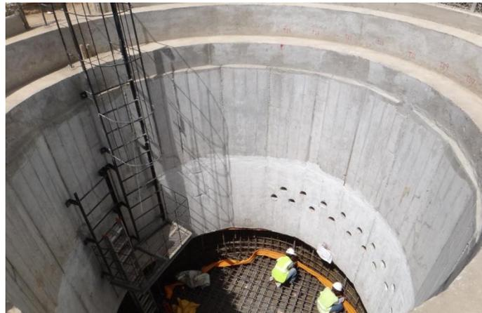
Foto 14. Excavación y Estructura de Pozos de Emergencia
