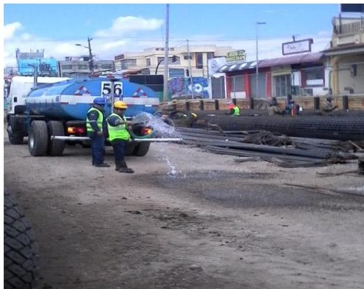
Foto 1: Hidratación del suelo descubierto en la Estación Jipijapa.
