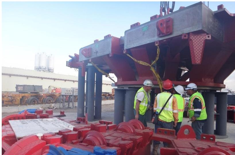
**Foto 35.** Armado inicial de Tuneladora
