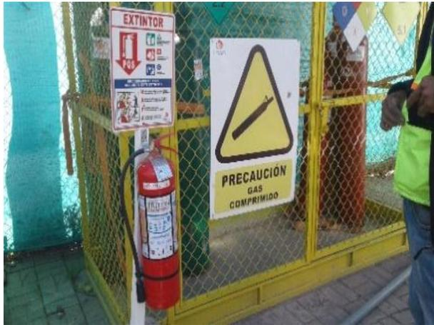
**Foto 52.- Islas de almacenamiento de oxígeno y acetileno que se disponen en los frentes de obra del Proyecto, cuentan con señalización, etiquetado y MSDS de dichos productos.**
