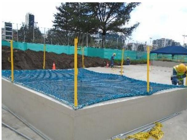
Foto 46.- Se verifica que la Contratista coloca la red de protección, alrededor de los ductos de ventilación como medida preventiva ante cualquier situación que pueda presentarse, Estación La Carolina.
