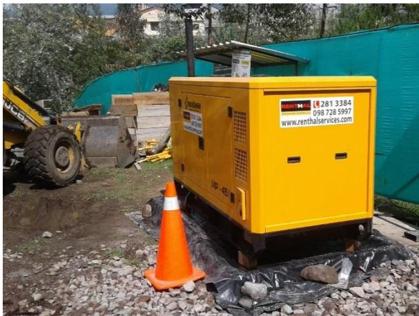
**Foto 14.- Colocación de impermeabilización bajo generador – Quebrada Río Grande.**
