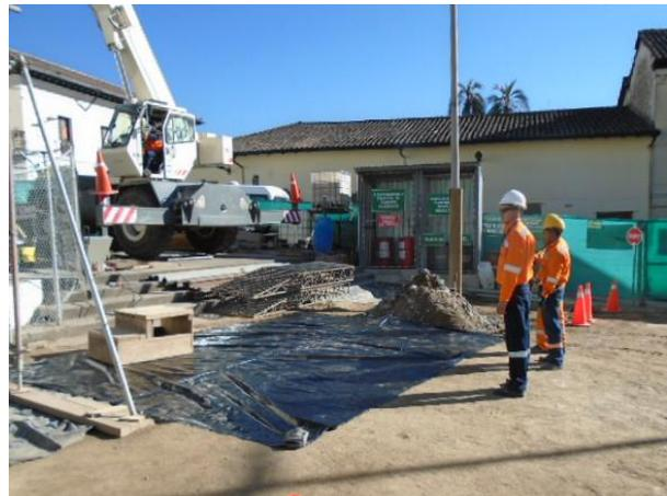
**Fotos 11 y 12.- Verificación de estado de cubetos para generadores y colocación de geomembrana para trabajos de hormigonado en Santa Clara.**
