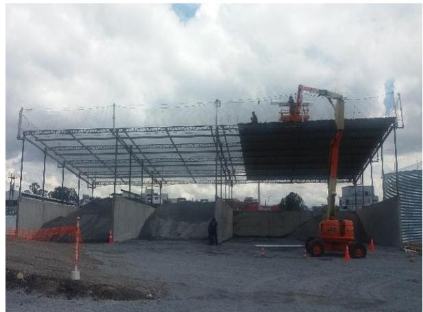
**Fotos 46 y 47.- EPP-EPC (red de seguridad, línea de vida y arneses) en la colocación de la cubierta del almacenamiento de los agregados de la planta de dovelas.**
