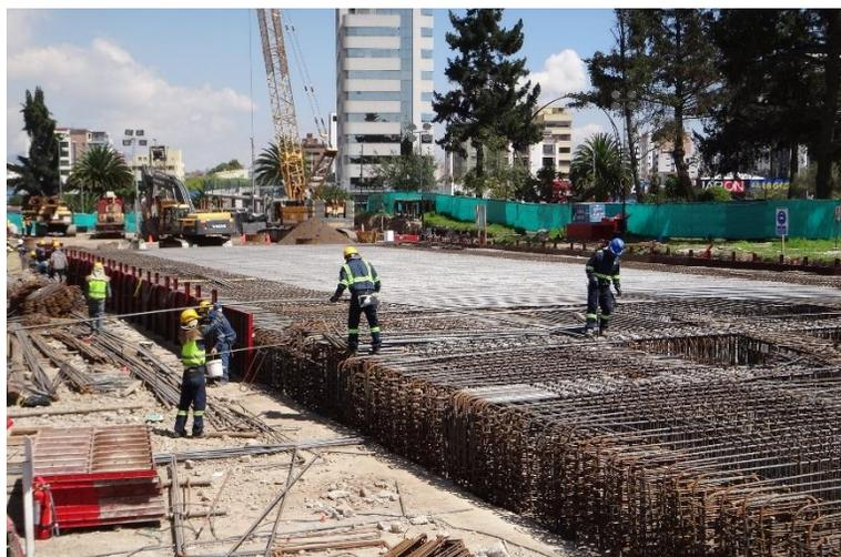
Foto 30. Armadura de Estructuras de Hierro
