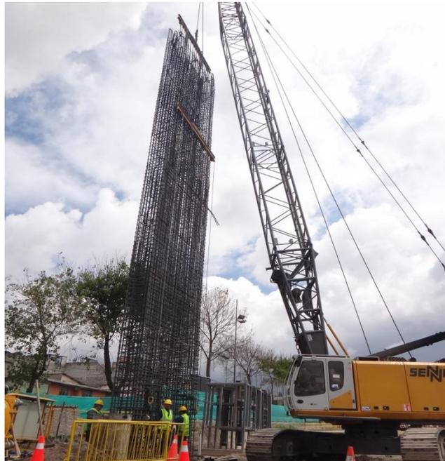
**Foto 15.** Pilotaje de Estación
