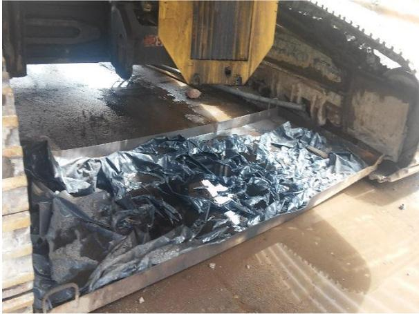
**Foto 12.- Colocación de cubeto anti derrame bajo maquinaria durante mantenimiento preventivo – Fondo de Saco.**
