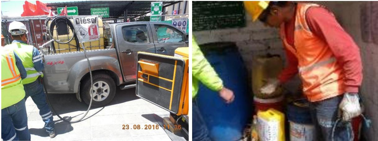
Fotos 12 y 13.- Control en el procedimiento de abastecimiento y almacenamiento de pequeñas cantidades de diésel en frentes de obra que se requiere.
