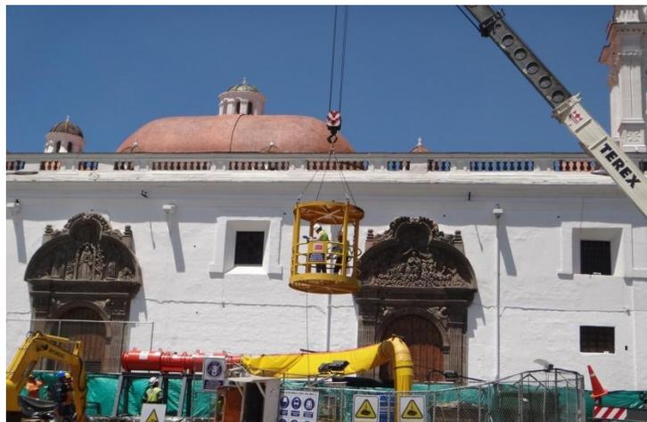
**Foto 23.** Izaje de Canasta de evacuación del Pozo de Emergencia en caso de emergencia
