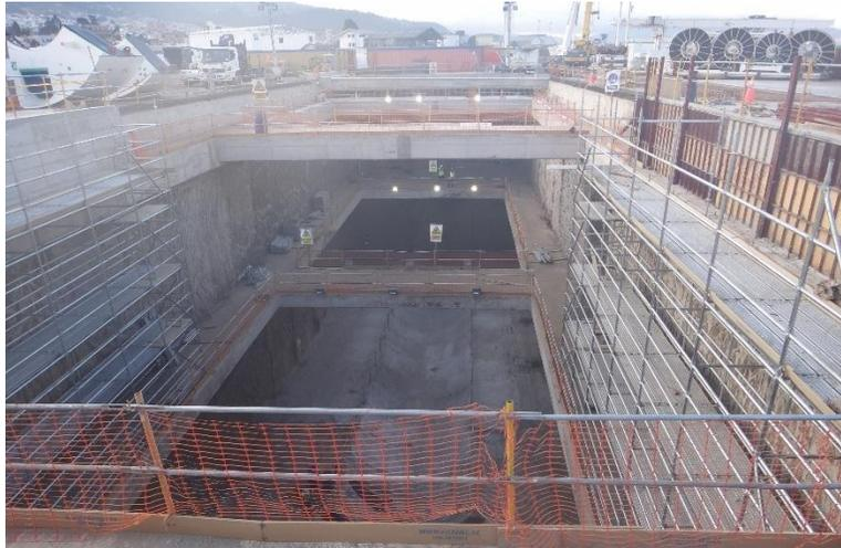
**Foto 36.** Preparación de Cuna para armado de Tuneladora
