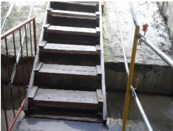
**Foto 42.- Colocación de gradas y barandas para el paso peatonal y acceso entre plataformas.**
