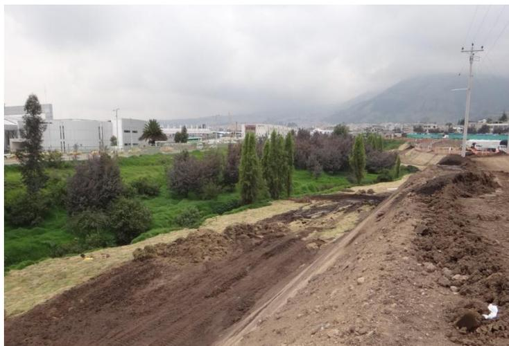
**Foto 7.** Conformación de Talud-Quebrada Alpallacta-El Carmen
