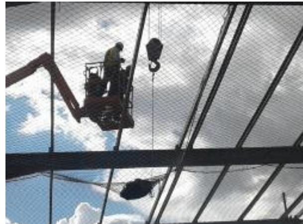
Fotos 73 y 74.- Pruebas de soporte de cargas de la malla de seguridad Patio de Dovelas-Sur.
