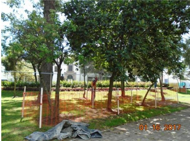
**Foto 28.- Protección de árboles en zona de construcción de colector – Estación El Ejido.**
