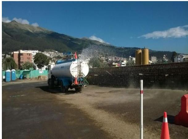
Foto 4: Hidratación del suelo descubierto en el Fondo de Saco.
