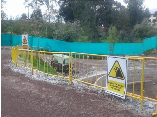
Foto 75.- Instalación de señalización de advertencia en excavaciones de Río Grande.
