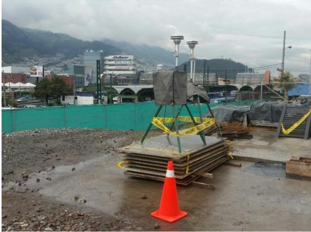
**Foto 116.- Instalación de equipo para monitoreo de Calidad del Aire – Estación El Recreo.**
