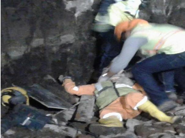
**Foto 83.-** Por descuido y desorientación durante la ejecución de desencofrado, se suelta una tabla de la retroexcavadora, dicha tabla golpea al trabajador que se encuentra cerca al sitio. ( Simulacro)
