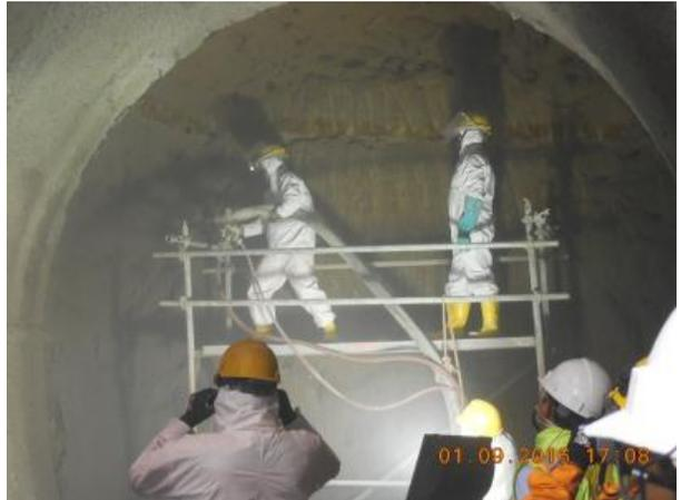
Foto 43.- Uso adecuado de EPP en el lanzamiento, de hormigón en Santa Clara.
