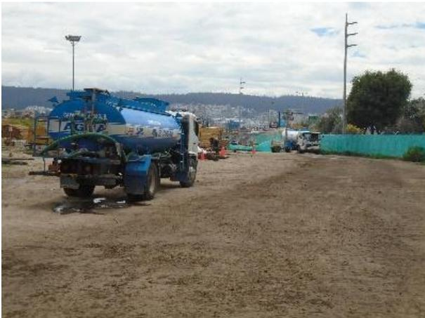
**Foto 3.- Hidratación del suelo Planta de Dovelas Norte.**
