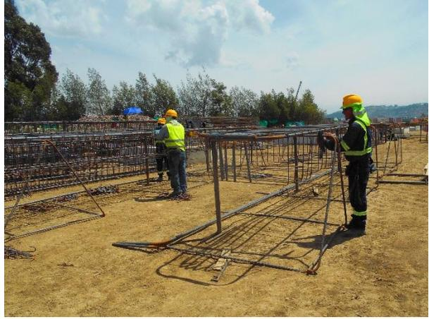
**Fotos 42 y 43.- Soportes para realizar actividades de armado y soldadura de hierro de estructuras para pantallas y pilotes para evitar que el personal ejecute éstas tareas a nivel del piso.**
