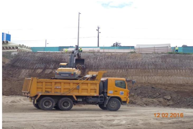
**Foto 3.** Conformación de Taludes
