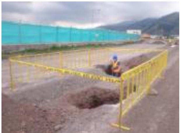
**Fotos 40 y 41.- Colocación de mallas, cintas de seguridad y señalización de advertencia en los sitios de excavaciones, perforaciones y cambios de nivel como medida de seguridad para los trabajadores.**
