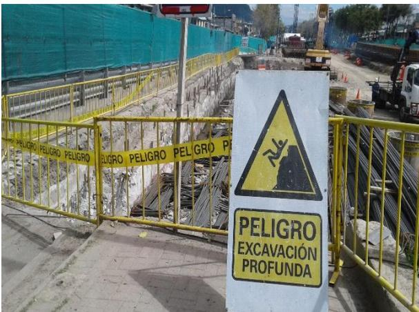
Foto 76.- Instalación de señalización de advertencia en excavaciones de El Calzado.
