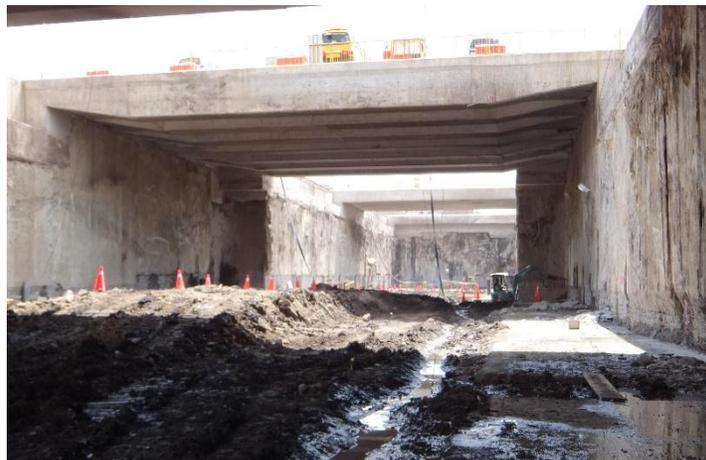
**Foto 13.** Cuna para armado de Tuneladora
