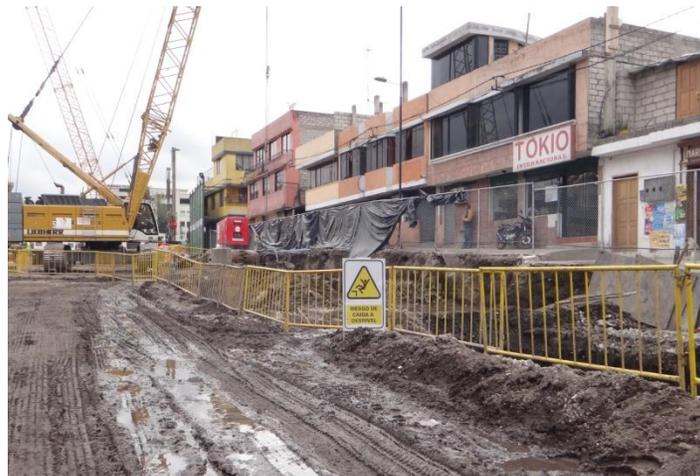
**Foto 9.** Trabajos de Pilotaje en el Frente de Obra
