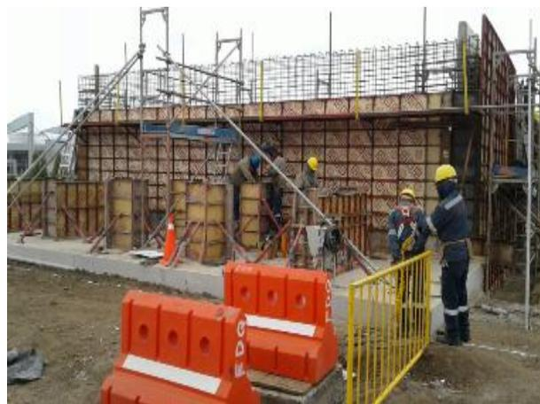
**Foto 33.-** Colocación de arnés y andamios para el armado de hierros del muro en el Patio de Dovelas-Sur.
