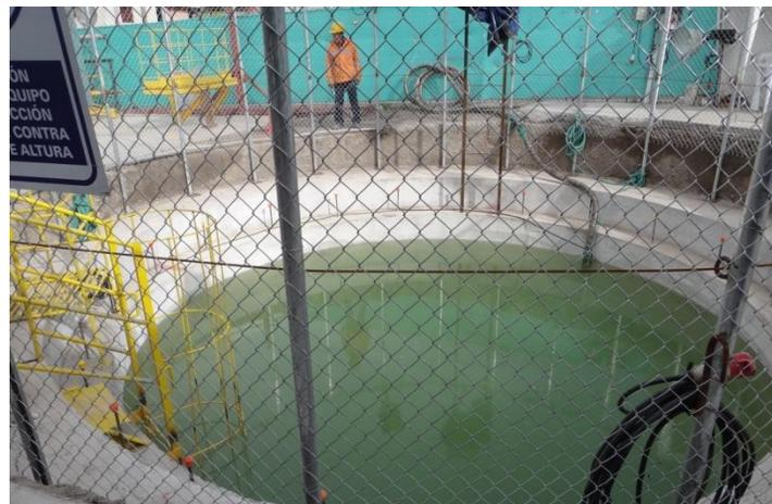
**Foto 10.** Excavación del Pozo de Emergencia 3PK
