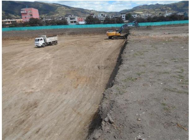
Fotos 19 y 20.- Carga y transporte de material de excavación en Estación Moran Valverde y Patio de Talleres.
