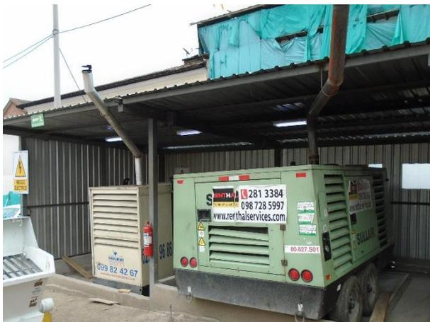
**Foto 9.- Aislamiento acústico de generadores y compresores mecánicos – Pozo de Santa Clara.**
