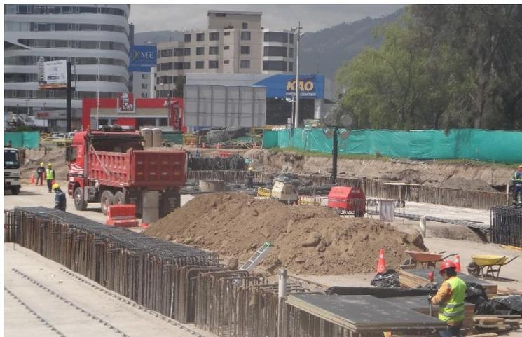
**Foto 29.** Preparación del sitio para Hormigonado.
