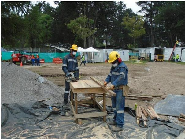
**Foto 11.- Protección del suelo con geomembrana para evitar contacto con residuo de materiales – El Ejido.**
