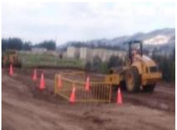
**Fotos 42 y 43.- Colocación de mallas, cintas de seguridad, conos en los sitios de excavaciones y conformación de accesos y gradas, como medida de seguridad para los trabajadores.**
