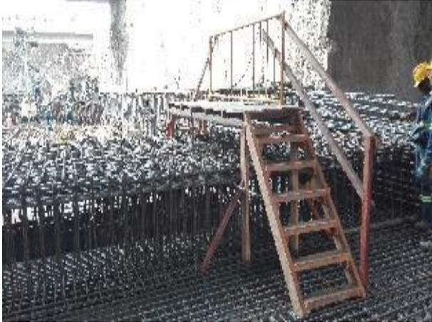
**Foto 41.- Colocación de gradas y barandas para el paso peatonal y acceso entre plataformas.**
