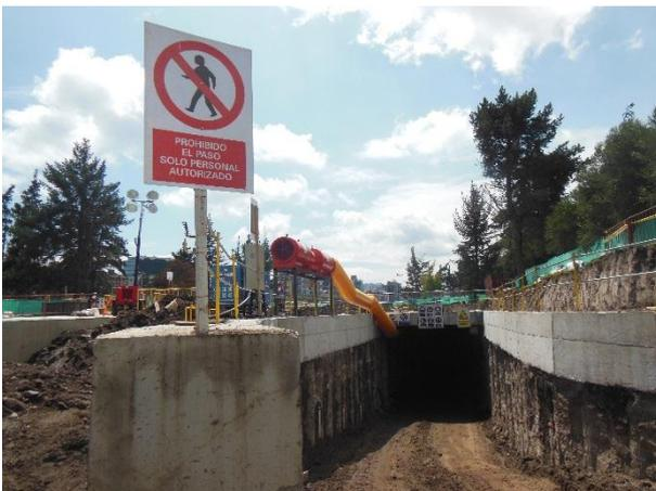
Foto 50.- La Contratista tiene instalado y en funcionamiento el sistema de ventilación en las obras subterráneas, Iñaquito.
