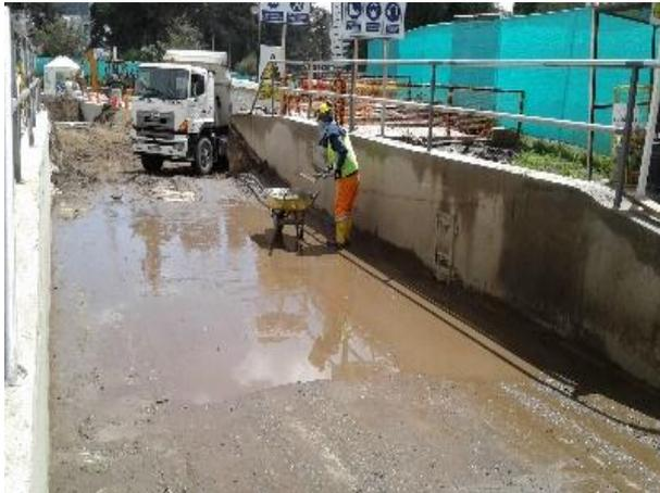
**Foto 9.- Limpieza de sistema de lavado de neumáticos – Estación Iñaquito.**
