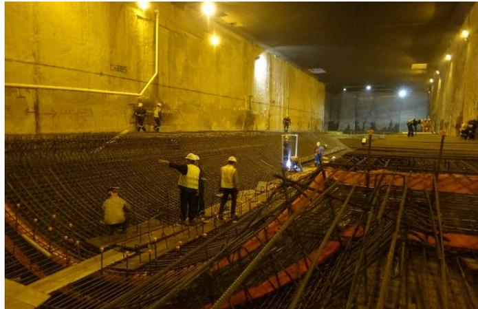
**Foto 19.** Montaje de Estructura Metálica en Túnel.
