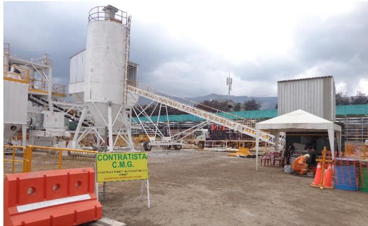
Foto 8. Montaje Planta de Hormigón
