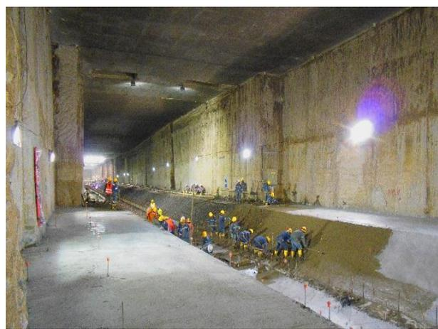
**Foto 67.- Uso de EPP adecuado para los trabajos de hormigonado de la contra bóveda de El Labrador.**
