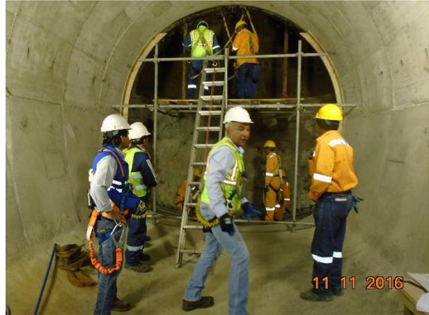
**Foto 51.- Uso de arnés y andamio en los trabajos realizados en el túnel de Santa Clara.**
