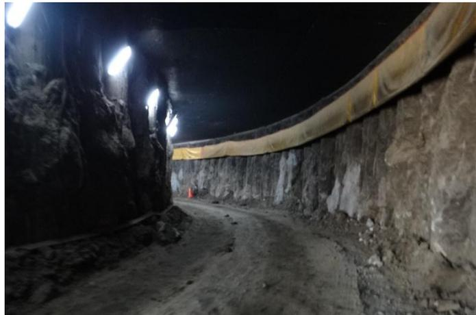
**Foto 12.** Excavación de Túnel para Desalojo de Material Excedente
