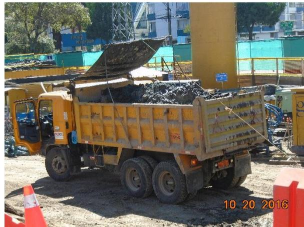
**Fotos 24 y 25.- Transporte de material de excavación.**
