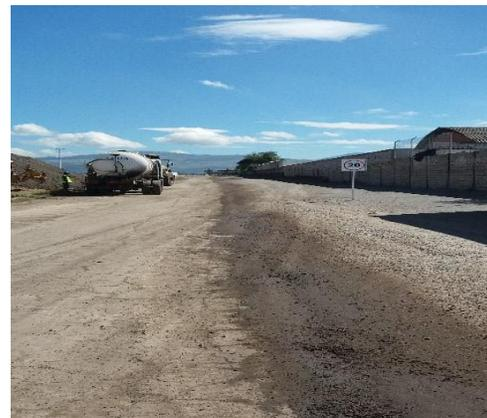
Foto 2.- Hidratación en la vía de acceso a Bicentenario.
