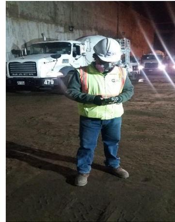
**Fotos 72 y 73.- Monitoreo de atmósferas peligrosas en las actividades de excavación en las Estaciones de Solanda y El Labrador.**
