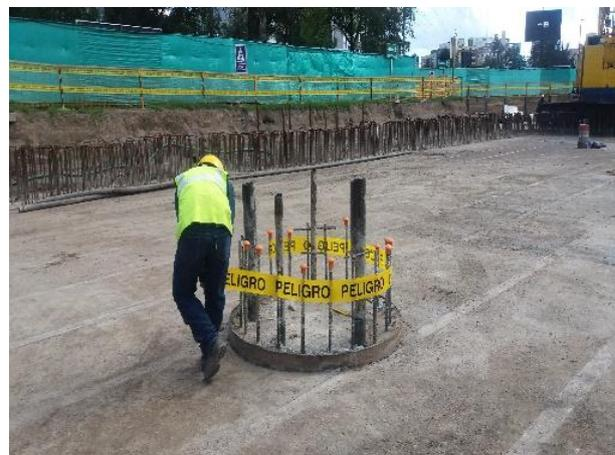
**Foto 37.- Colocación de capuchones en "puntas vivas" como medida de seguridad para los trabajadores.**
