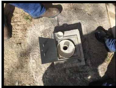
3. Patio De Talleres (1608376- AG002)
