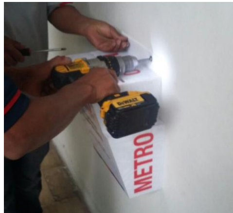
Foto 2. Instalacion de pernos decorativos.
