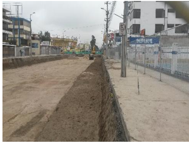
Foto 92.- Control ambiental en la excavación en el frente de Jipijapa.
