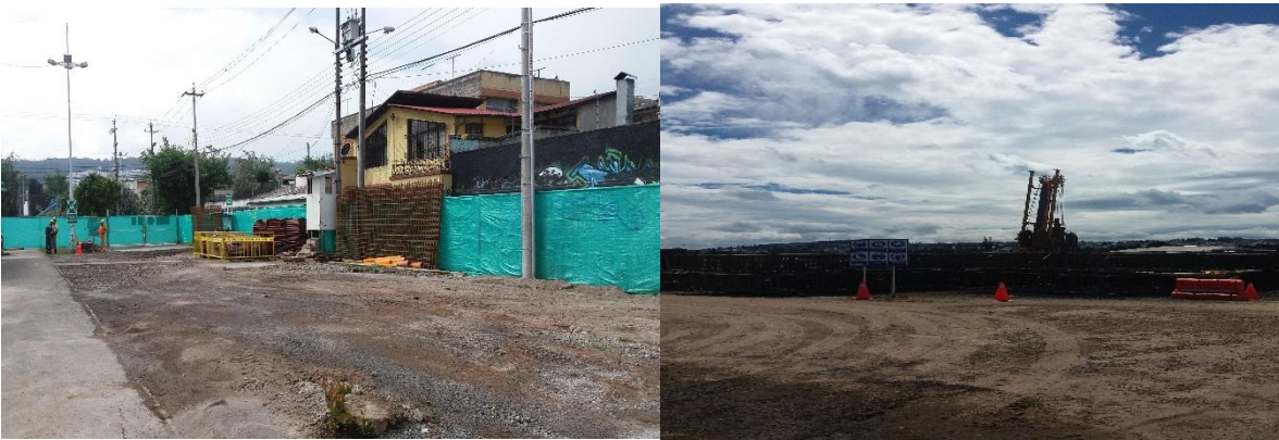
Fotos 126 y 127.- Frentes de obra limpios y ordenados
