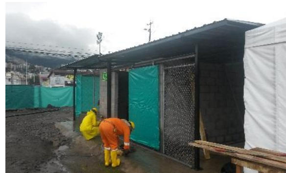
Foto 62.- Construcción y adecuación del "punto limpio" en la Estación Jipijapa
