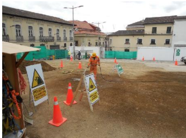
Foto 140.- Hidratación del suelo descubierto en Santa Clara.
