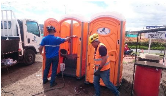
Foto 57.- Mantenimiento de letrinas en Patio de Talleres y Cocheras
