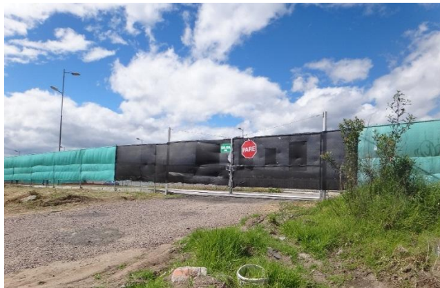
Foto 16. Instalación de Cerramiento perimetral Frente de Obra
