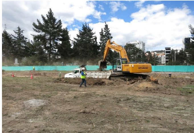
Foto 12. Corta de árboles y Movimiento de Tierras Estación Iñaquito
