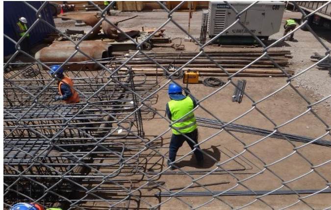
Foto 15. Armaduras para pantallas
