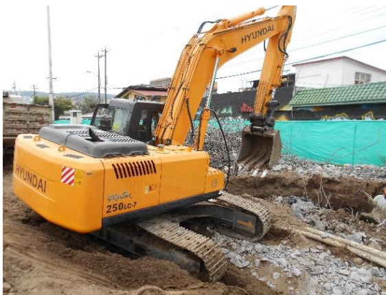
Foto 29.- Pantalla para evitar la dispersión del ruido Estación Jipijapa.
