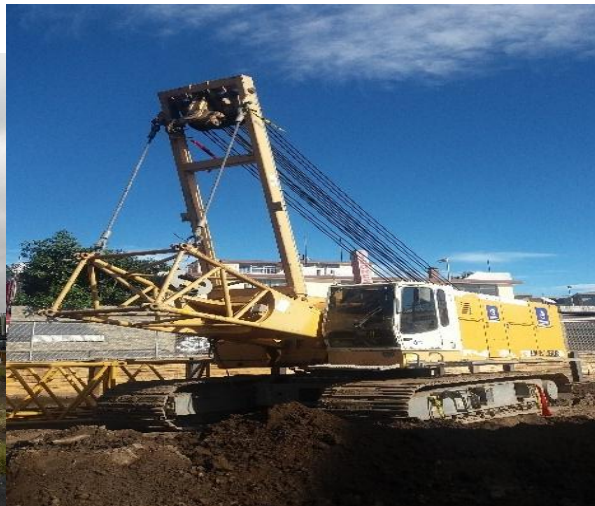
Foto 119.- Grúa de castillo en el Fondo de Saco.
