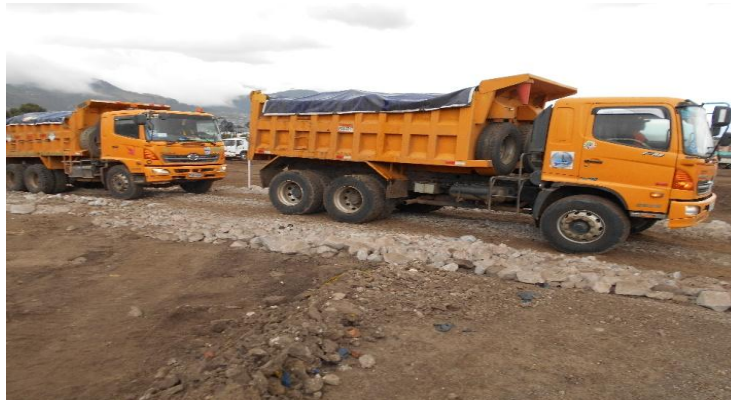
Foto 34.- Transporte del Material en el frente de obra Patio Talleres y Cocheras.
