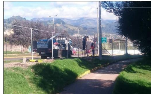
Foto 20.- Construcción de cerramiento Perimetral.
