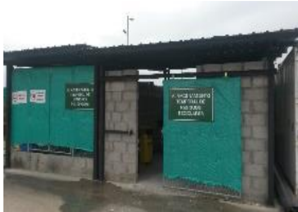
Foto 115.- Sitio de almacenamiento temporal de desechos peligrosos-Fondo de Saco.
