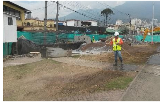
Foto 54.- Control del material particulado
