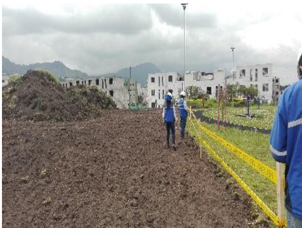
Foto 91.- Control ambiental en el descapote para reubicación de la Rumichaca.
