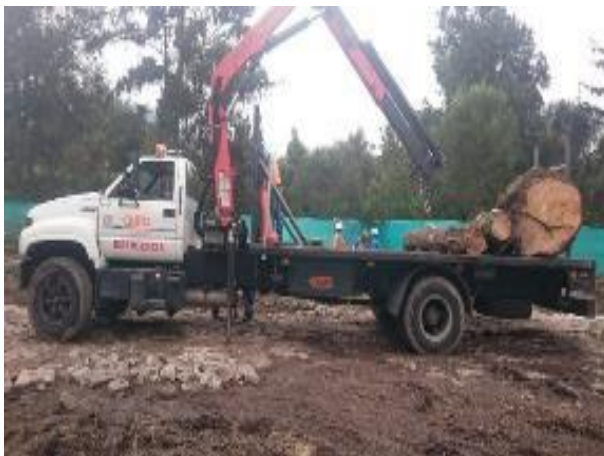
Foto 110.- Transporte de trozas Estación Carolina de madera por parte de EMMOP.
