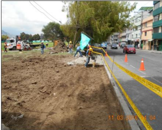
Foto 35.- Adecuacion de acceso en la estacion "Solanda"
