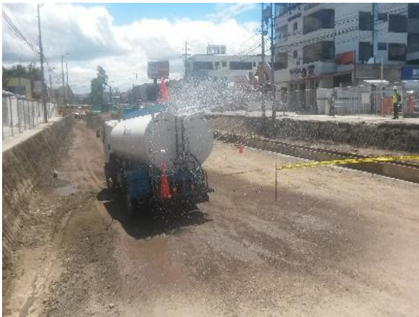
Foto 79.- Hidratación para control de material particulado en la Estación Jipijapa.
