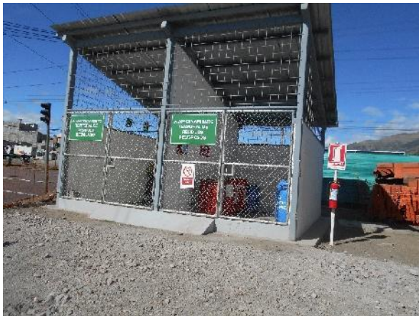
Foto 166.- "Punto limpio" de Patio de Talleres y Cocheras.
