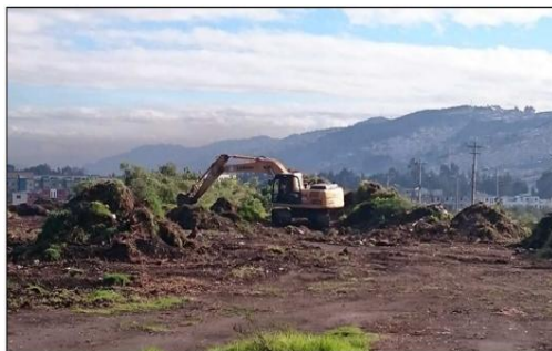
Foto 19.- Desalojo de material de Desbroce.
