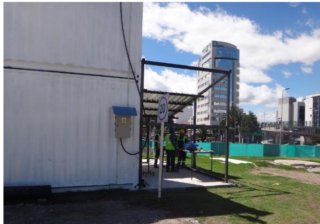
Foto 13. Instalación de Campamento Iñaquito
