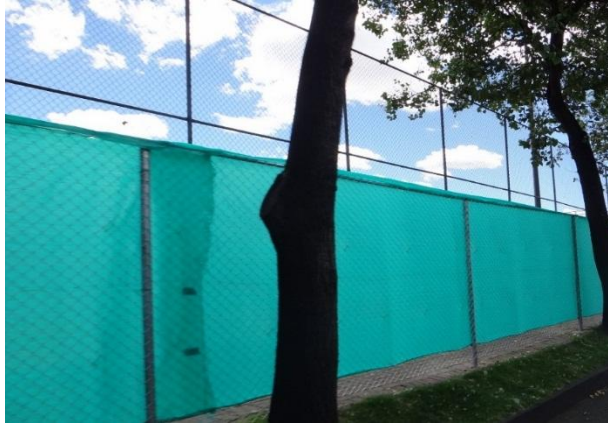
Foto 7. Cerramiento perimetral del Frente de Obra el Calzado
