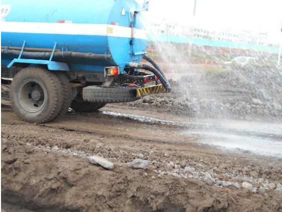
Foto 24.- Hidratación de la vía en Patio de Talleres y Cocheras.
