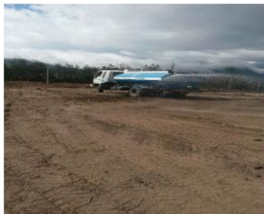
Foto 22.- Hidratación del sitio de obra.
