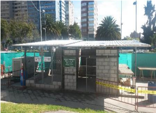
Foto 114.- Sitio de almacenamiento temporal de desechos peligrosos-Estación Iñaquito.
