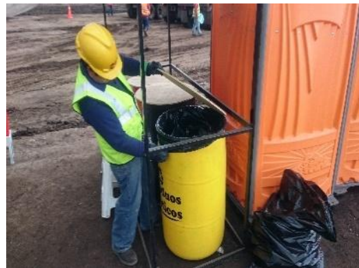
Foto 41.- Construcción del sitio de disposición temporal Patio de Talleres y Cocheras.
