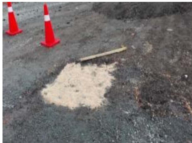
Foto 84.- Control de derrames en patio de Talleres y Cocheras.
