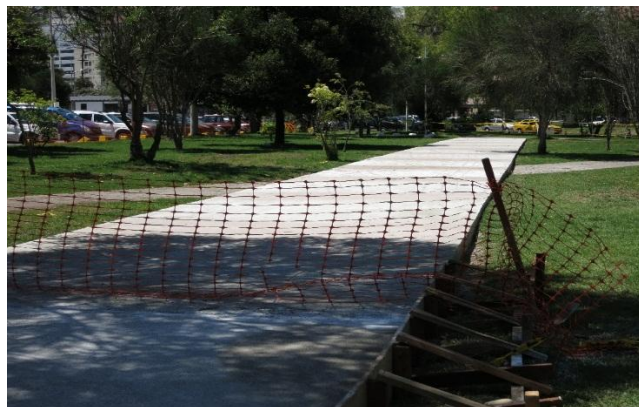
Foto 11. Construcción de Ciclo-vía
