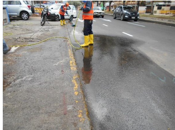
Foto 25.- Limpieza de material excavado en Estación Jipijapa.
