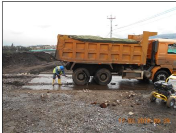
Foto 31.- Lavado de Volquetes previo a su salida de la plataforma de trabajo de Patio de Talleres y Cocheras.
