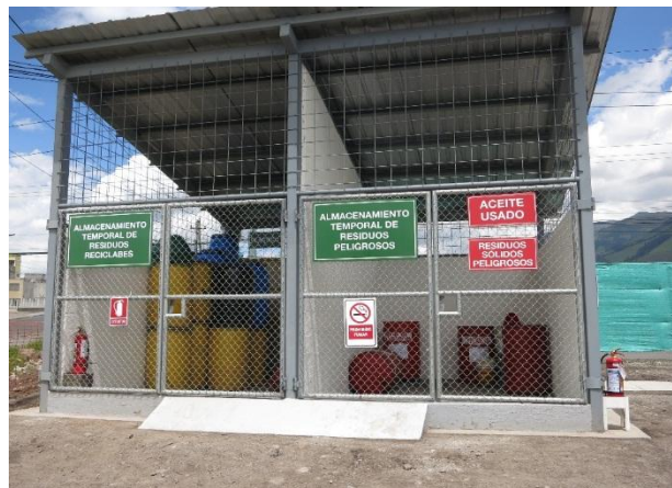
Foto 2. Punto Limpio Patios y Cocheras Quitumbe
