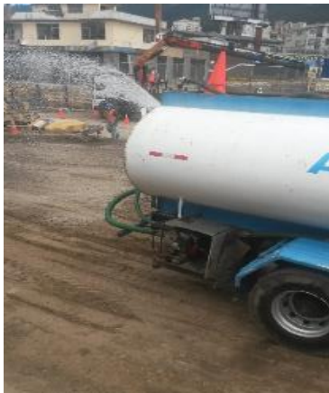
Fotos 97 y 98.- Hidratación para control de material particulado en los frentes de obra.
