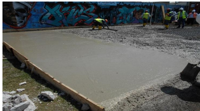
Foto 42.- Adecuación loseta para “Punto Limpio” Estación Jipijapa.
