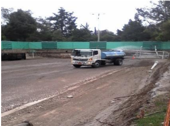
Foto 138.- Hidratación del suelo descubierto en la Estación La Carolina.
