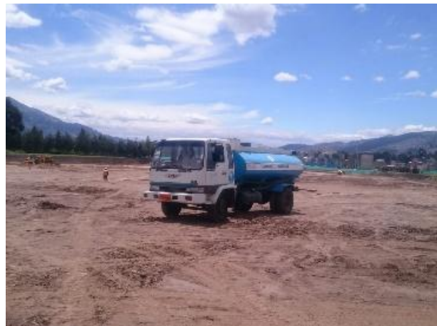
Foto 78.- Control del material particulado mediante un tanquero.
