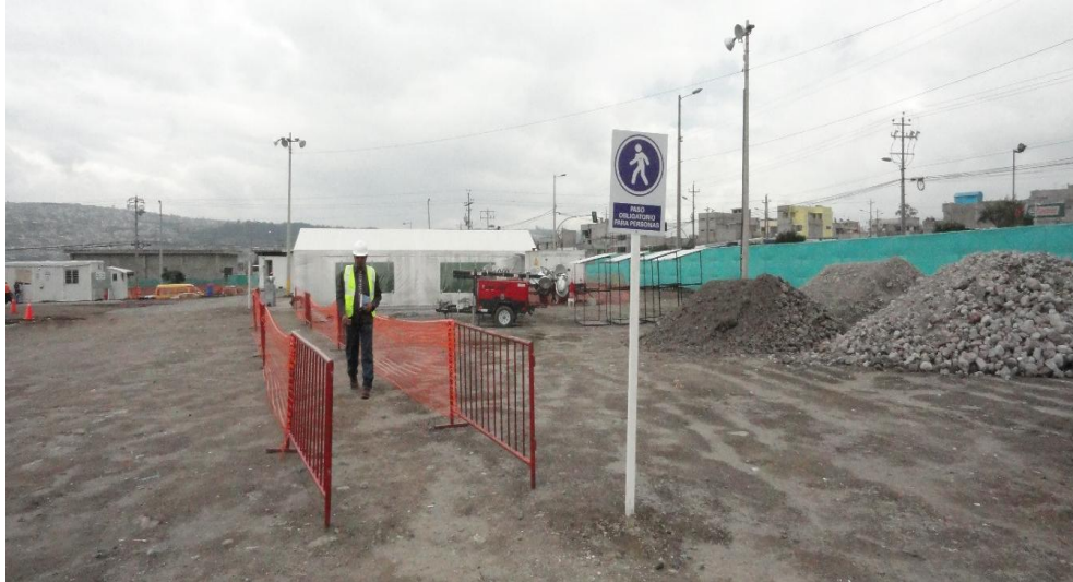
Foto 52.- Sendero para el trayecto de personal. Patio de Talleres y Cocheras
