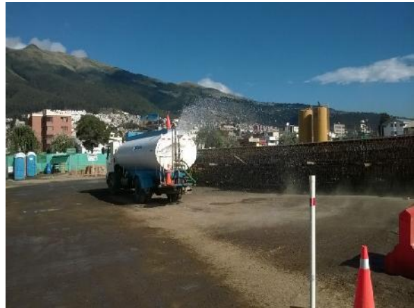
Foto 139.- Hidratación del suelo descubierto en el Fondo de Saco.
