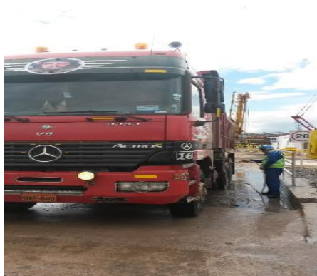
Foto 101.- Lavado de neumáticos en frentes de obra.
