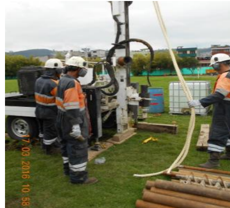
Foto 36.- Inicio de Sondeos de Suelos en la "Solanda"
