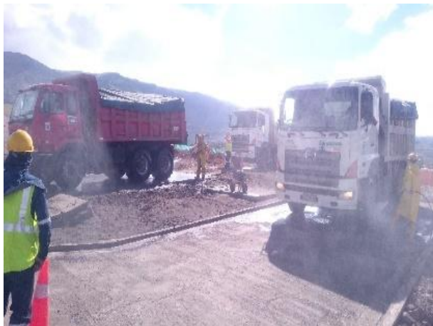
Foto 77.- Limpieza de los neumáticos en Patio de Talleres y Cocheras
