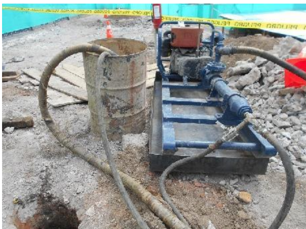
Foto 152 y 153.- Equipo y sitios de sondeo de suelos en Estación San Francisco.
