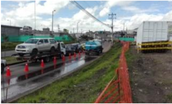
Foto 53.- Limpieza de la Avenida Rumichaca
