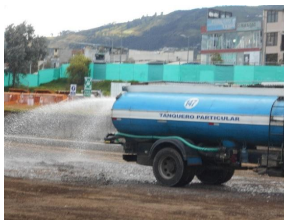
Fotos 97 y 98.- Hidratación para control de material particulado en los frentes de obra.
