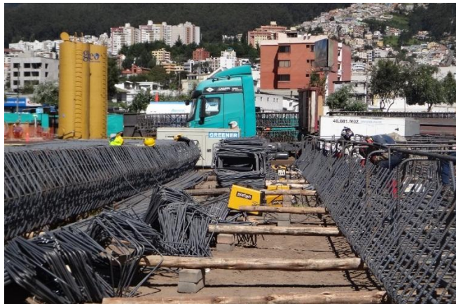
Foto 17. Armadura de pantallas en Fondo de Saco
