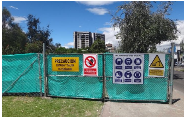
Foto 10. Instalación de Cerramiento perimetral
