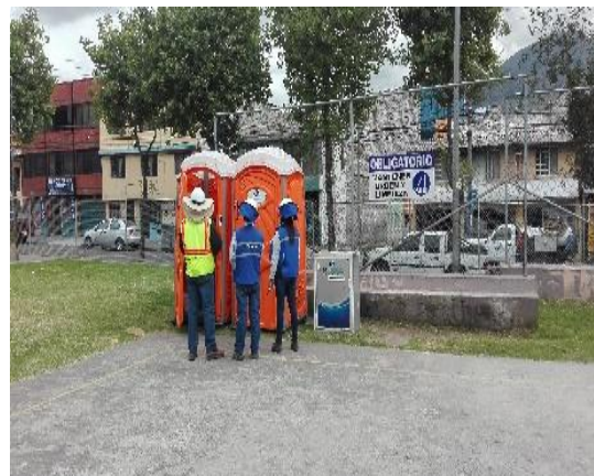
Foto 82.- Verificación del mantenimiento de letrinas en el frente de El Calzado.
