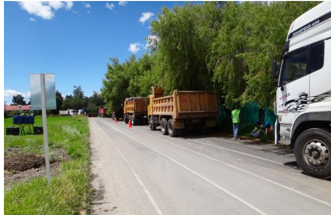
Foto 6. Volquetas para Movimiento de Tierras en Solanda
