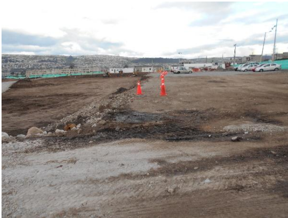
Foto 26.- No existen drenajes naturales en Patio de Talleres.
