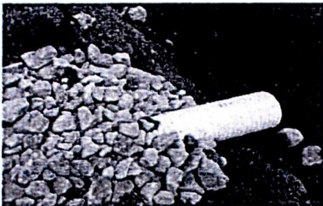
Foto 3: Colocación geotextil, control líquidos
