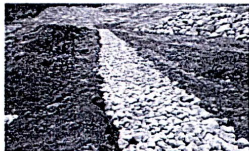
Foto 6: Cobertura de tubería, dren completo
