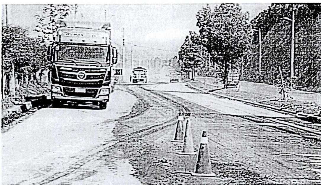
Estado de la Av. Simón Bolívar, cerca de ingreso a la escombrera El Troje 4. 21/05/2017
