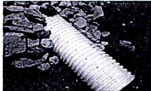
Foto 4: Colocación de piedra como agregado
