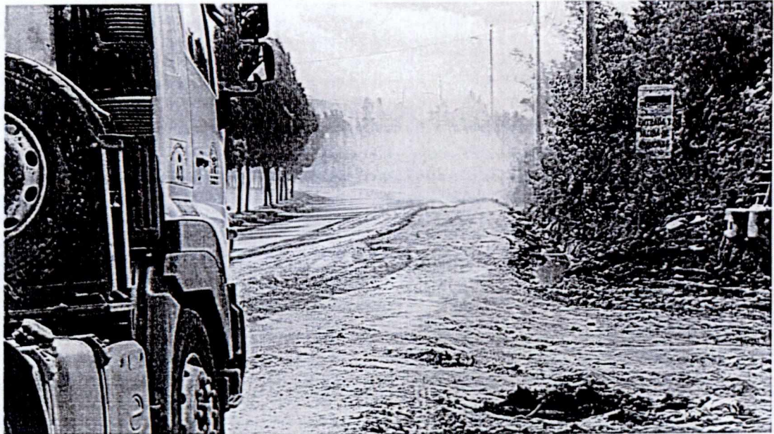
Estado de la vía de entrada y salida a la escombrera El Troje 4. Se aprecia el paso de tanquero pero no es suficiente para evitar generación de polvo. 21/05/2017
