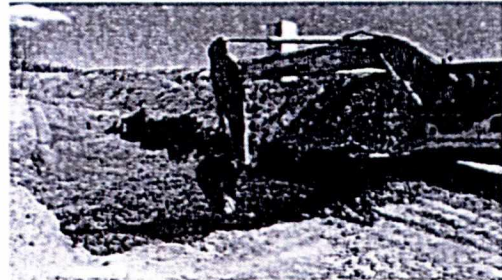
Foto 2: Abertura de zanjas drenes
