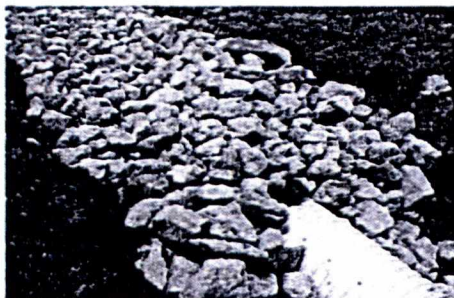
Foto 5: Ubicación de tubería corrugada
