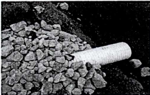
Foto 3: Colocación geotextil, control líquidos
