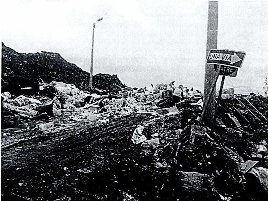
Señalética en mal estado y no legible. 20/05/2017
