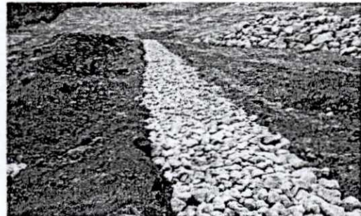
Foto 6: Cobertura de tubería, dren completo
