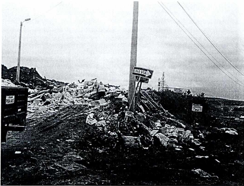
No existen áreas para la segregación de materiales reciclables. Estos se segregan y son retirados directamente por el personal que trabaja en la escombrera. 20/05/2017
