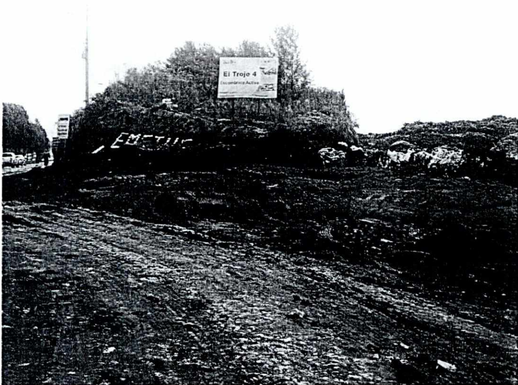
Vía de ingreso/salida de escombrera activa El troje 4 hacia la Av. Simón Bolívar. 20/05/17
