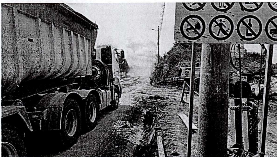
Estado de la Av. Simón Bolívar y vía de entrada y salida a la escombrera El Troje 4. 21/05/2017
