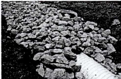
Foto 5: Ubicación de tubería corrugada
