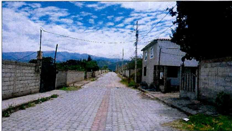
8.1.3 Canal par conducción de agua lluvia en la parte posterior de la franja de lotes (67 - 85) del AHHYC "Nueva Esperanza de Guayllabamba".
