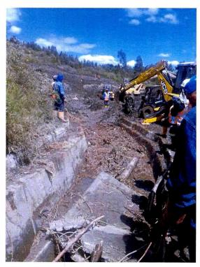
Posteriormente se realizó el encofrado y fundido de las paredes del canal que se vieron afectadas, terminando este trabajo alrededor de las 12h00 del día 7.
