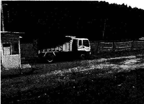
Foto 1: Correcto ingreso de volquetas a la escombrera con tolva
