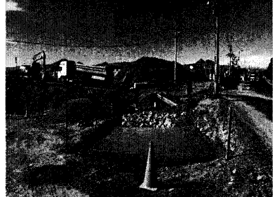
Foto 2: Construcción de piscina para la limpieza de neumáticos a la salida de la escombrera
