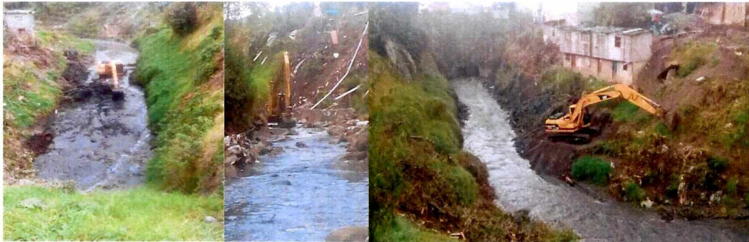
Fotografías: Limpieza, corrección de cauce y protección de taludes (Quebrada Caupicho)
