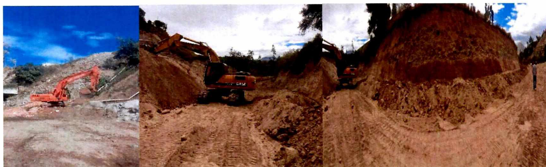
Fotografias: Limpieza, correccion de cauce y proteccion de taludes (Rio Monjas)
