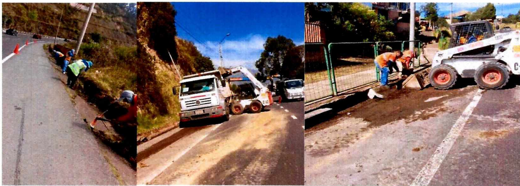
Fotografías: Limpieza y mantenimiento de cunetas viales (Av. Simón Bolívar)
