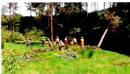
Fotografias: Intervencion de maquinaria y cuadrillas (Quebrada Capuli)
