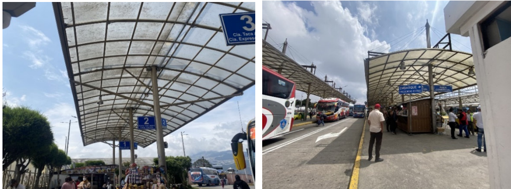
Fotografía Nro. 8 Cubiertas de Policarbonato – Embarque / Desembarque
