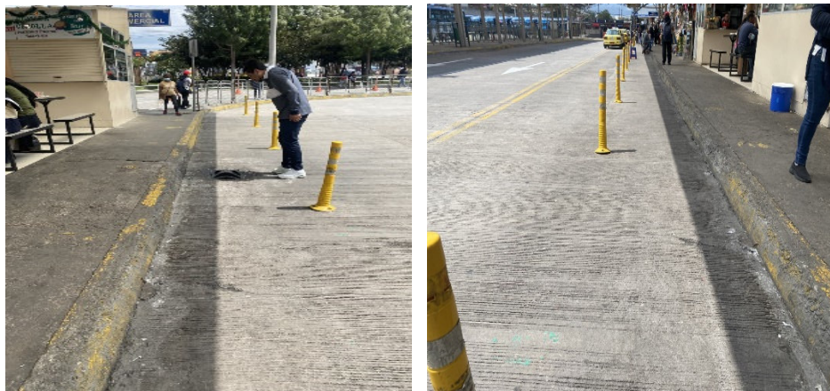
Fotografía Nro. 5 Acera de circulación peatonal
