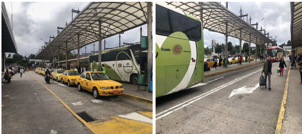
Fotografía Nro. 1 Ingreso Vehicular TTC
