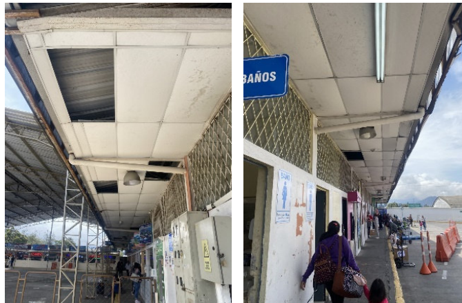
Fotografía Nro. 9 Techo área de Boletería y Encomiendas
