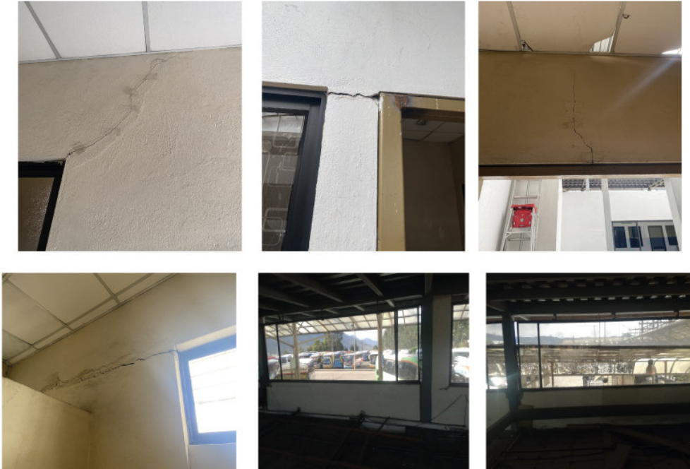
Fotografía Nro. 6 Edificio Oficinas Administrativas – Estado Actual
