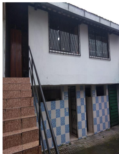
Construcción 2: Oficinas del GAD
