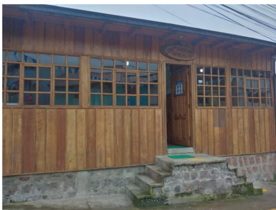
Construcción 1: Oficinas del GAD
