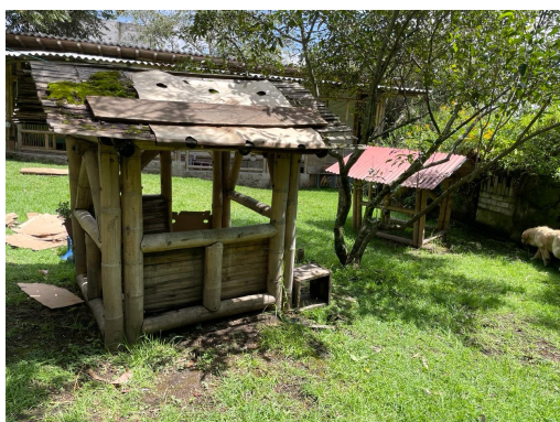
Imagen 14: Elementos elaborados por las personas que se capacitan en construcción con bambú
