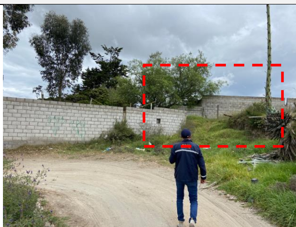
Imagen N° 6: Vista tramo 2 – sin acceso por cerramiento.
