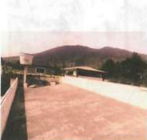
Foto N°25 Vista de terraza inclinada
