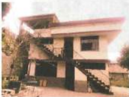
Foto N° 1 Vista de fachada principal
