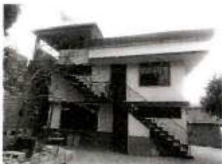
Foto N° 1 Vista de fachada principal
