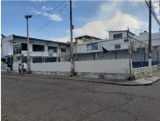
Fotografía 1: Vista exterior hacia el cerramiento
