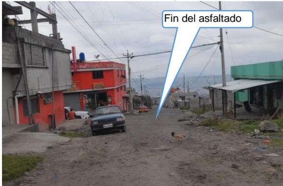
FOTO 8: “Tramo en tierra sin bordillos, calzada variable”
