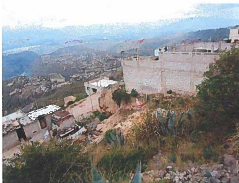
Foto 6. Desbanque de tierra efectuado para una posible construcción futura en el lado oriental del Barrio Los Eucaliptos de Calderón. Note la gran inclinación de la ladera y la densidad de edificaciones sobre la misma.
