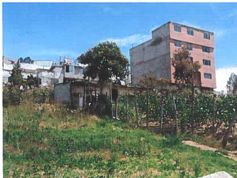
Foto 7. Tipologías constructivas en el lado oriental del Barrio Los Eucaliptos de Calderón.
