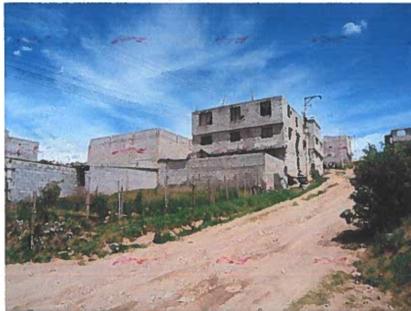
Foto 4. Vista del lado occidental del Barrio Los Eucaliptos de Calderón. La pendiente es menor que en el lado opuesto. Note la falta de obras de control de la escorrentía pluvial y el tamaño de las construcciones.
