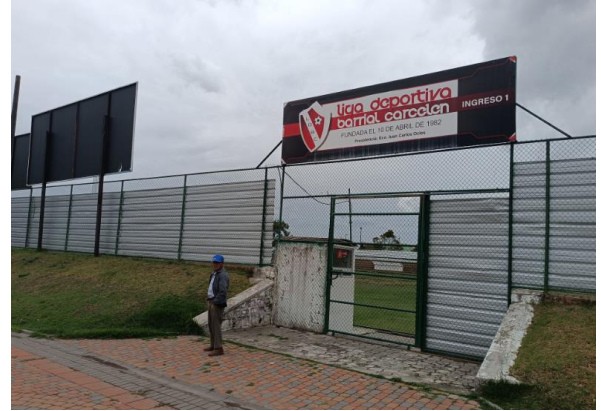
Fotografía 2: Vista exterior hacia el ingreso principal.
