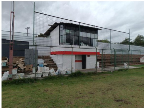
Fotografía 5: Vista interior hacia las áreas de: baterías sanitarias y salon multiuso.
