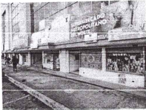
Fotografía 1 fachada posterior del predio
