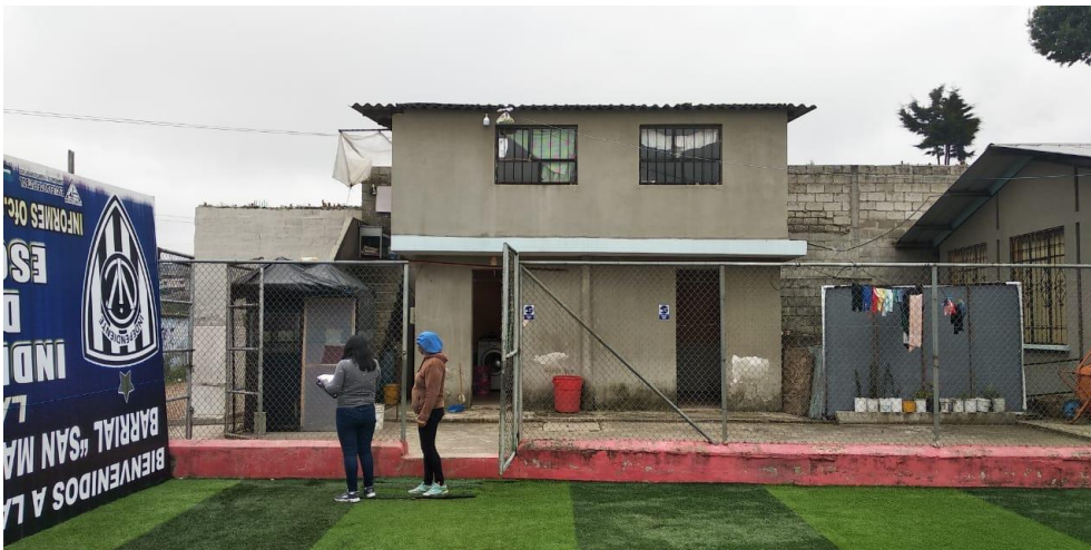
Fotografía 2. Construcción de hormigón armado 2 plantas.
