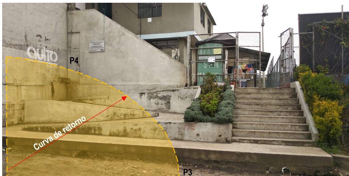
Imagen 2. Rampa – Grada de acceso hacia el predio.
