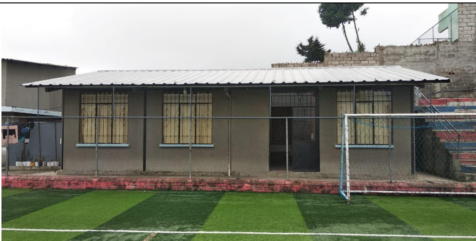
Fotografía 3. Construcción en estructura metálica (Sede Social).
