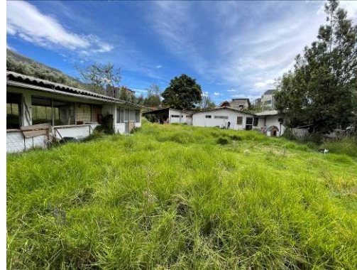
Imagen 2: Vista patio con vegetación crecida
