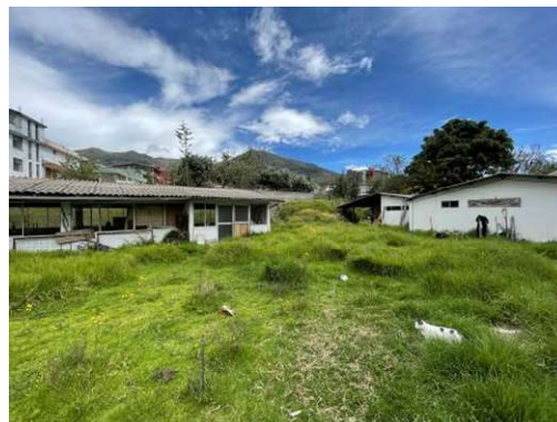
Imagen 4: Vista general de los bloques constructivos existentes
