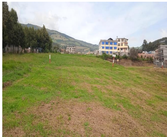
Fotografía 6: Faja de protección del oleoducto
