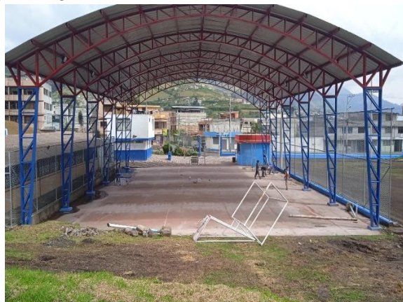
Fotografía 2: Cancha de uso múltiple cubierta (nueva)
