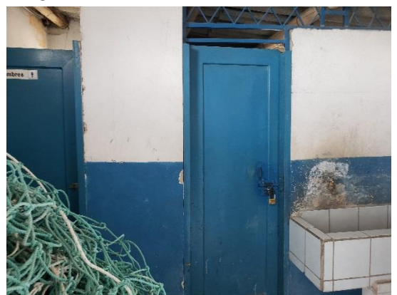
Fotografía 3: Vista interior, baños
