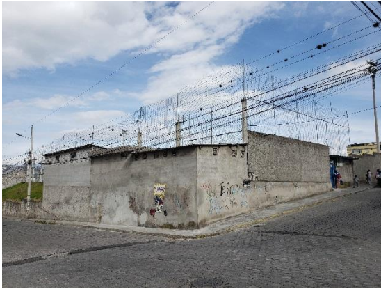
Fotografía 1: Cerramientos de: Calle E8 y Calle 91
