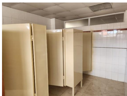
Fotografía 4 baños públicos en PB
