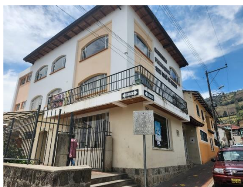
Fotografía 2 vista frontal de la edificación
