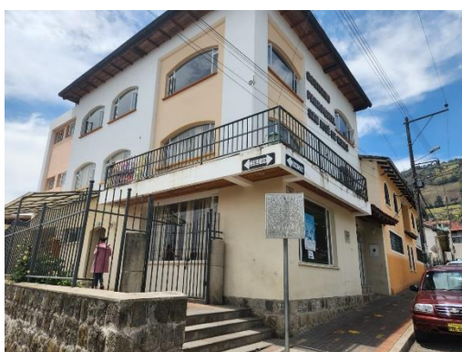
Fotografía 1 vista frontal de la edificación
