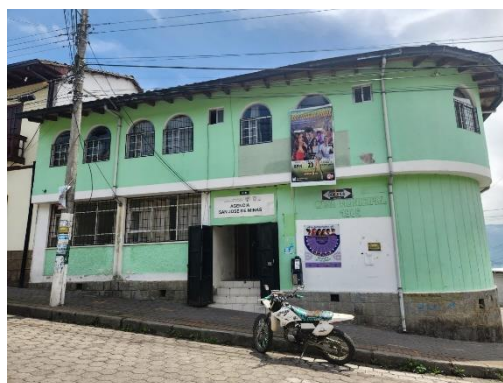
Fotografía 2 vista frontal de la edificación
