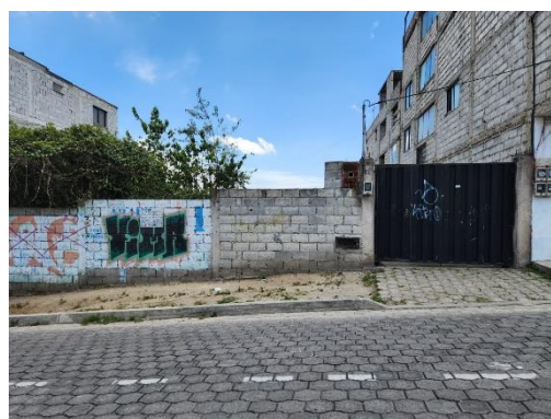
Fotografía 6 cerramiento de la construcción lado sur
