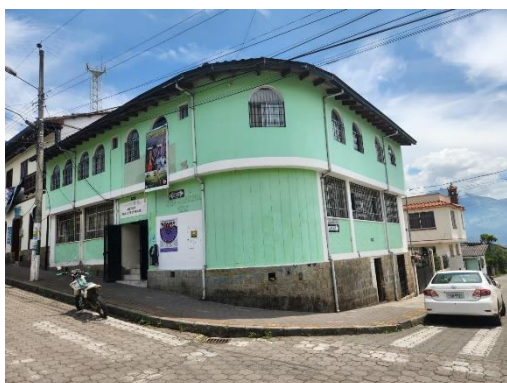
Fotografía 1 vista frontal de la edificación
