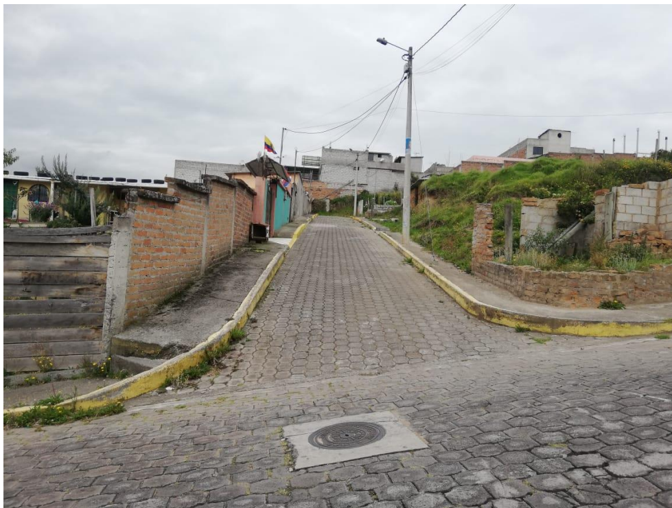
Fotografía 1. Pasaje Oe12D- Estado actual consolidada con bordillos, aceras y una capa de rodadura adoquinada.
