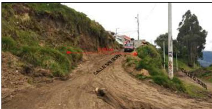
En el espacio físico donde se implanta la propuesta vial se forman 2 taludes, no se adjunta el diseño geométrico horizontal y vertical con sus cortes longitudinal y transversal respectivos, de la manera como se encuentra actualmente esta vía, por el tráfico que existe en el sector resulta insuficiente su ancho y su geometría puede ocasionar fallas y deslizamientos de los taludes.
