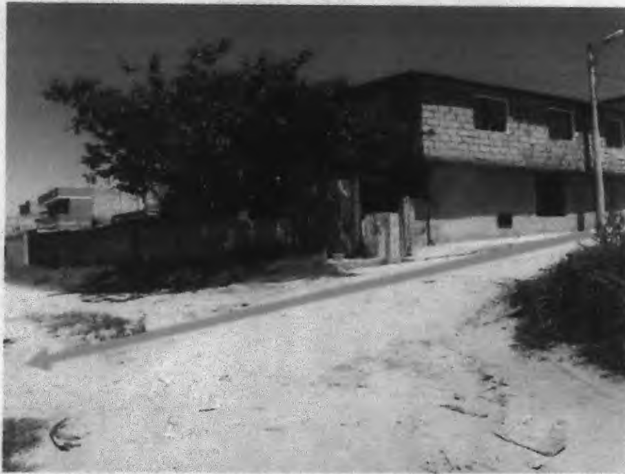
Vía adojonada "CALLE 2 - 8.00 m" de acceso al predio del señor Vicente Ushifa
