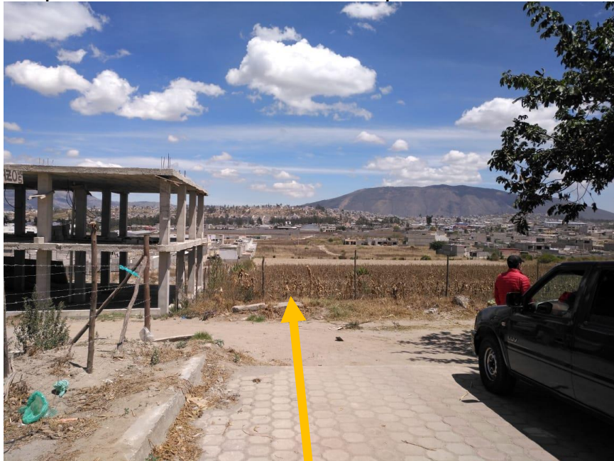
Vía adoquinado "CALLE 2 - 8.00 m" predio del señor Vicente Ushiña
