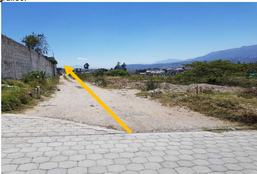
INICIO CALLE FERNANDO GUACHAMIN
