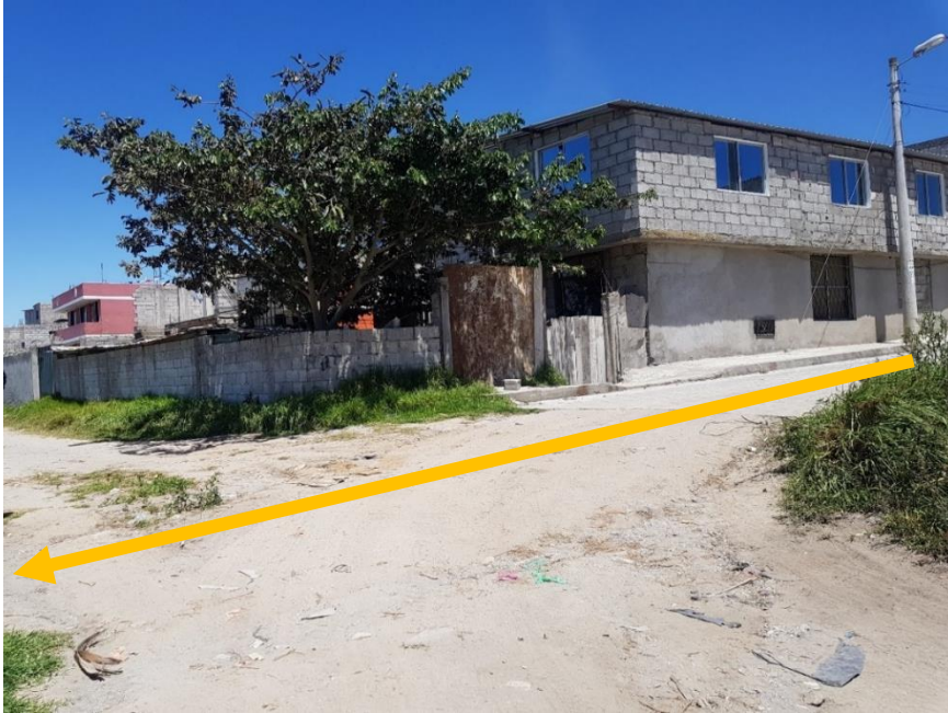
Vía adoqionada "CALLE 2 - 8.00 m" de acceso al predio del señor Vicente Ushiña
