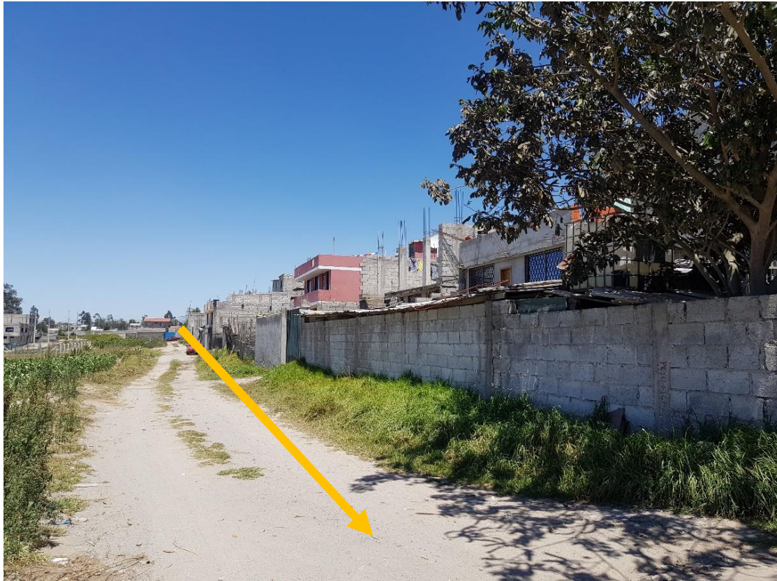
FINALIZACION DE LA CALLE FERNANDO GUACHAMIN
