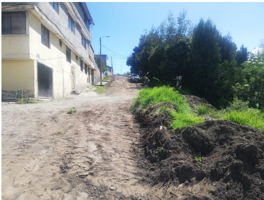
Fotografía 4. Calle S43 (Calle principal A)
