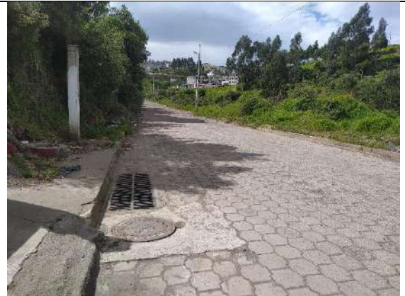
Fotografía 7.1.8. Calle 11 adoquinada, sumideros y bordillos
