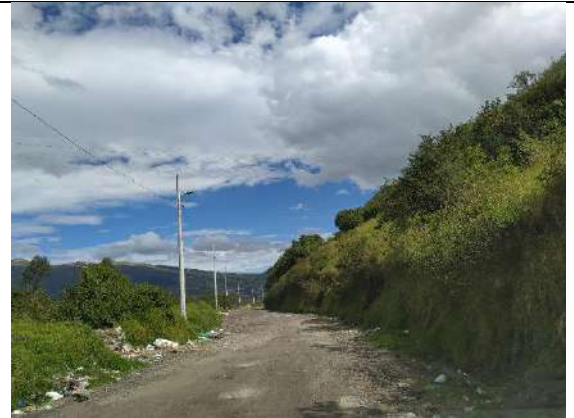
Fotografía 7.1.2. Calle 11 de suelo natural afirmado, basura y escombros a los extremos de la vía.
