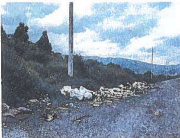
Gráfico 7: Calle "11" (E7C), tramo en tierra, con postes de electricidad instalados
