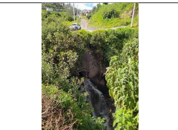
Fotografía 7.1.6. Estructura hidráulica colindante a la Calle 11
