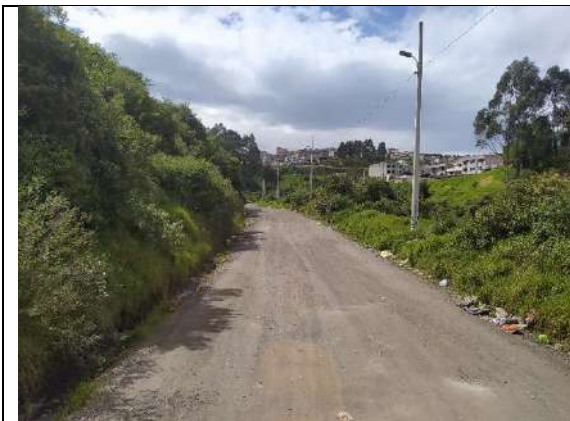
Fotografía 7.1.3. Calle 11 de suelo natural afirmado.
