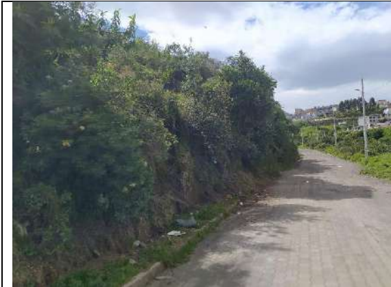
Fotografía 7.1.7. Calle 11 parcialmente adoquinada
