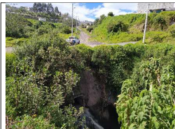
Fotografía 7.1.5. Estructura hidráulica colindante a la Calle 11
