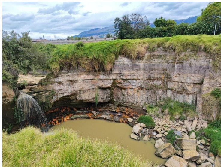
Foto 2. Caída de agua, cuenco disipador de energía natural
