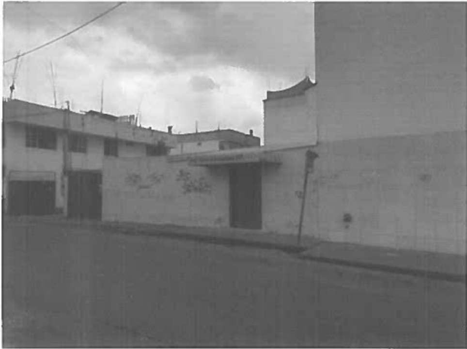
Figura 5. Entrada principal al lote, por la calle Matilde Álvarez
