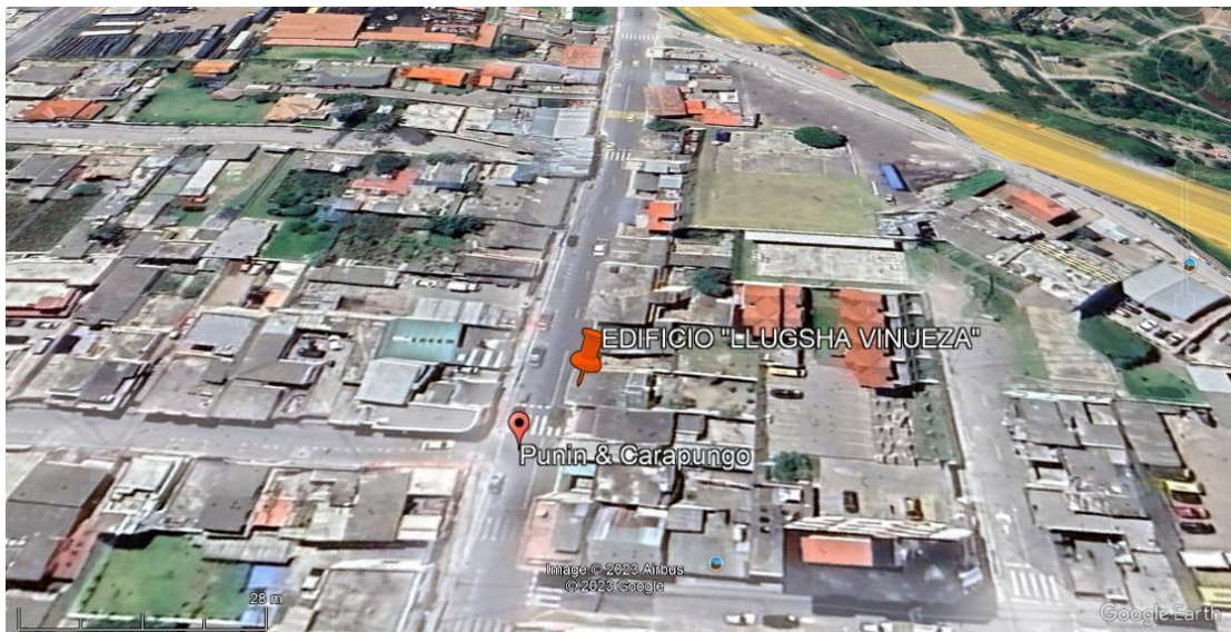
Figura 1. EDIFICIO "LLUGSHA VINUEZA".
