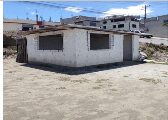
Construcción (interior del predio)
