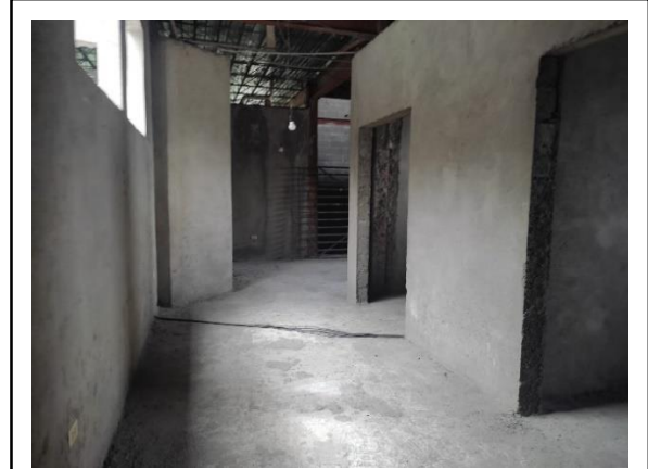
Fotografía 6: Bloque 1 - Primera Planta Alta (Obra Gris)
