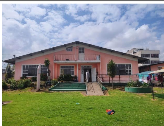
Fotografía 7: Bloque 2 - Fachada Frontal - Guardería
