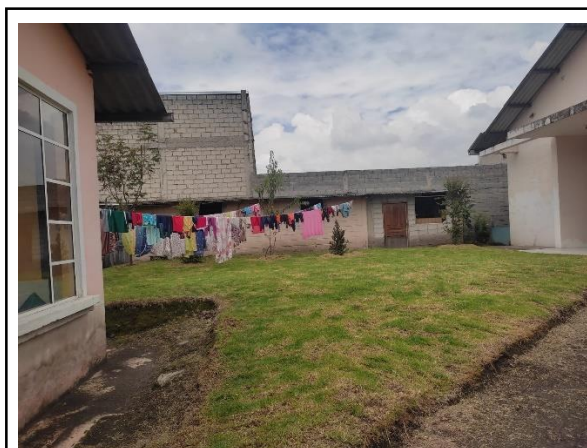
Fotografía 17: Bloque 4 – Fachada Bodega
