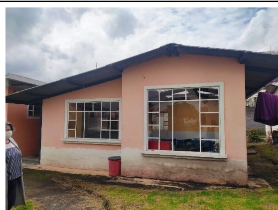
Fotografía 8: Bloque 2 - Fachada Frontal - Piscina
