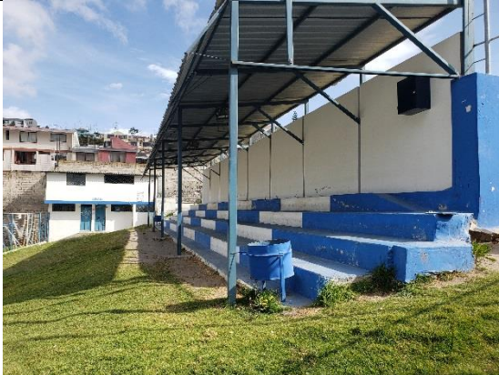
Fotografía 3: Vista interior, graderío cubierto con galvalumen
