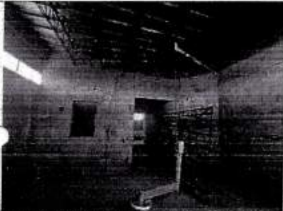
Imagen N° 3: Vista del proceso constructivo en el segundo piso.
