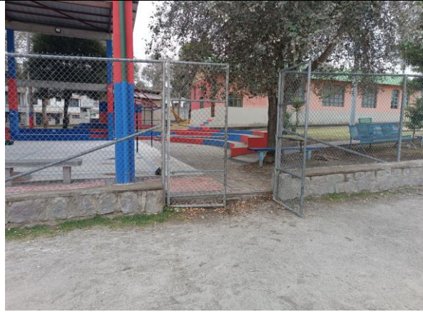
Foto 1: Acceso Sur en el interior del predio.
