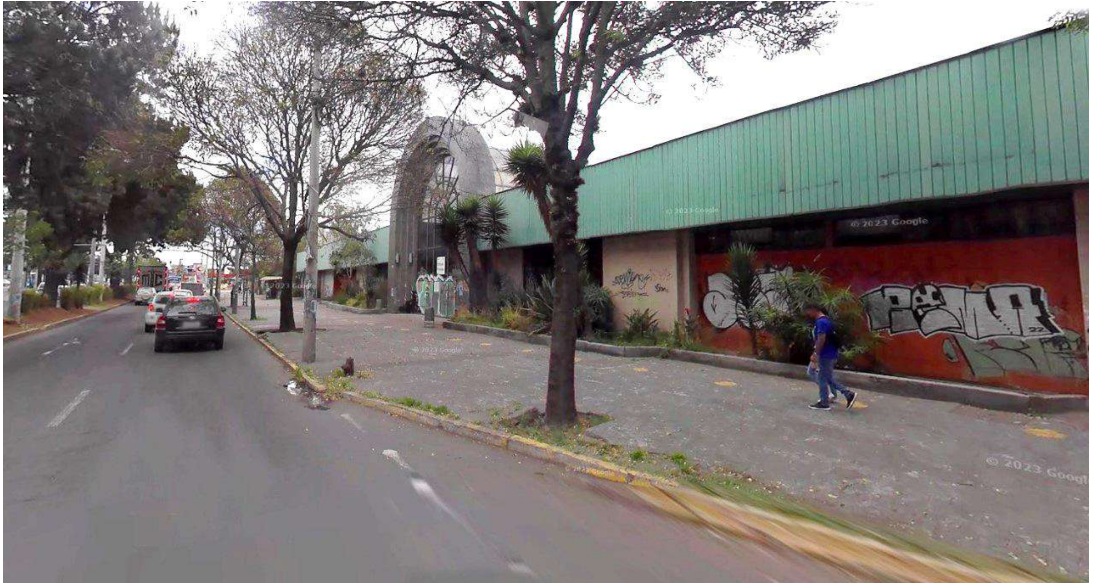
Obra para la liberación y adecuaciones menores en crujía de la ex estación del trole "La Y"
