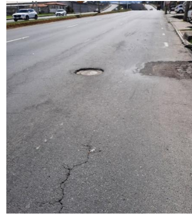
Foto 2. Grieta longitudinal y Calzada derecha
