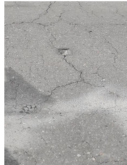
Foto 2. Grieta longitudinal y Calzada derecha
