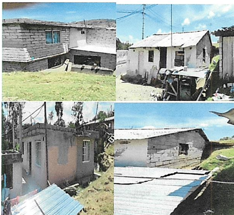
Gráfico 2. Vivienda con calidad estructural reducida del AHHyC “Curiqingue II Etapa”.
