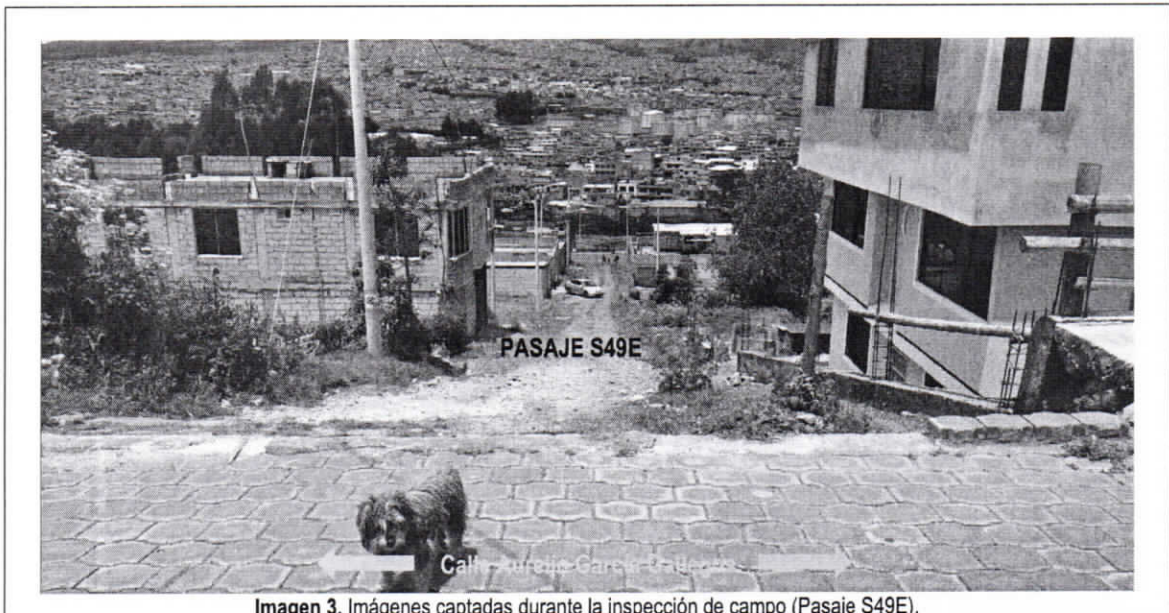
Imagen 3. Imágenes captadas durante la inspección de campo (Pasaje S49E).
