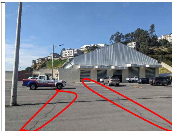
Fotografía 3. Vista frontal de edificación tipología 1 del Centro de Revisión Técnica Vehicular "La Cristiana".
