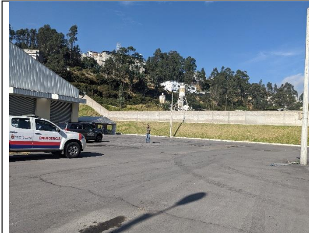
Fotografía 5. Vista desde el interior de cerramiento perimetral al predio.
