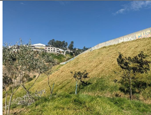
Fotografía 6. Vista desde el exterior de cerramiento perimetral al predio.
