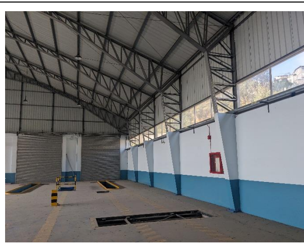
Fotografía 8. Vista del interior de edificación tipología 1. Se observa estructura metálica como sistema estructural.
