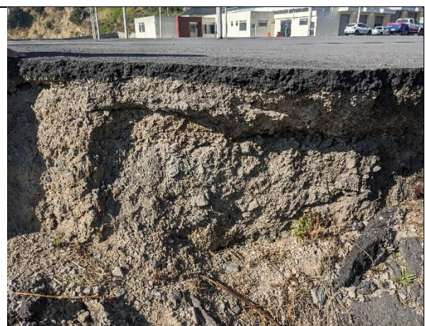
Fotografía 22. Vista de suelo bajo capa asfáltica de parqueadero del predio. No hay indicios de haber sido compactado el suelo.
