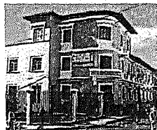
Fachada calle Sucre, antes y después de la intervención
