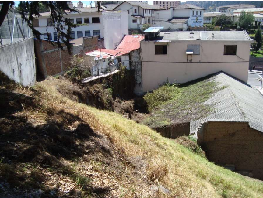
COMEDOR DE TROPA: LEVANTAMIENTO, ESTADO DE EDIFICACIÓN
