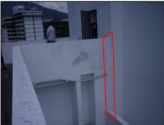
8.1.3: Juntas de construcción (Juntas sísmicas)
